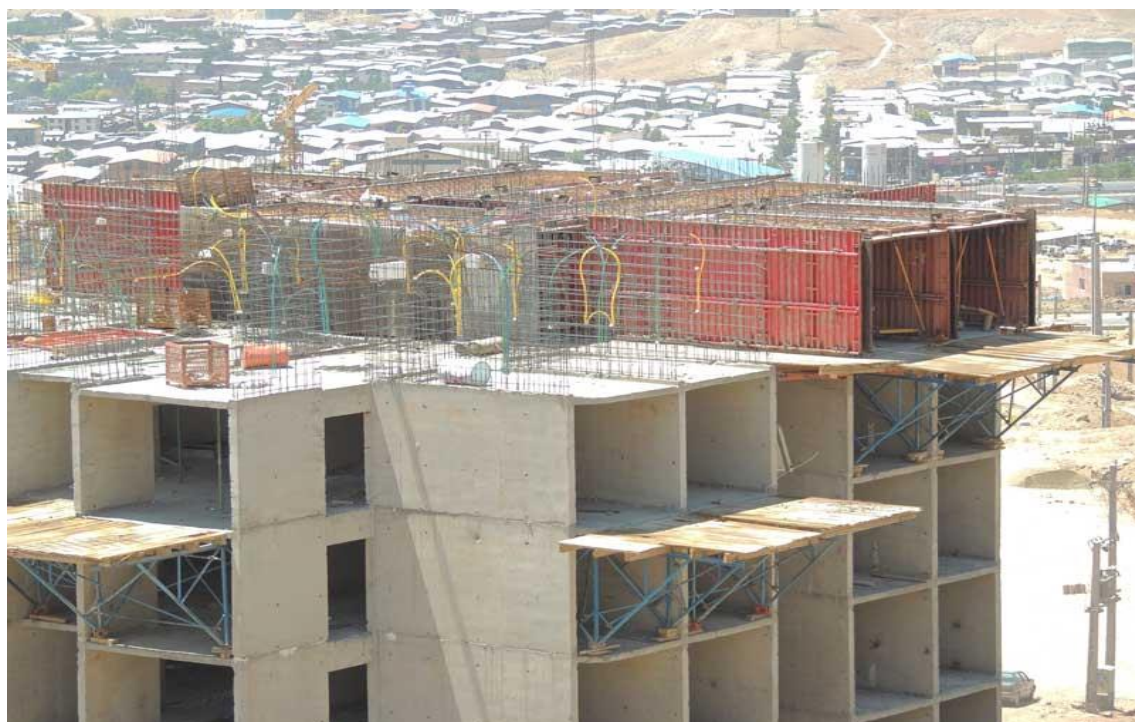
شکل ۱- سازه بتنی به روش قالب تونلی
