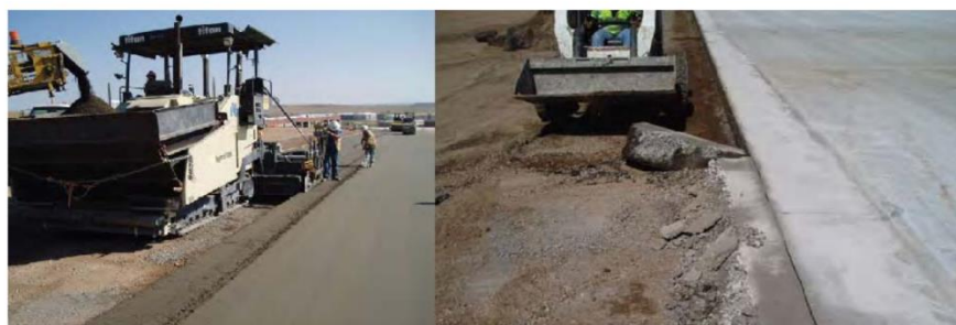
شکل ۲-۱۴ : اجرای درزهای طولی
