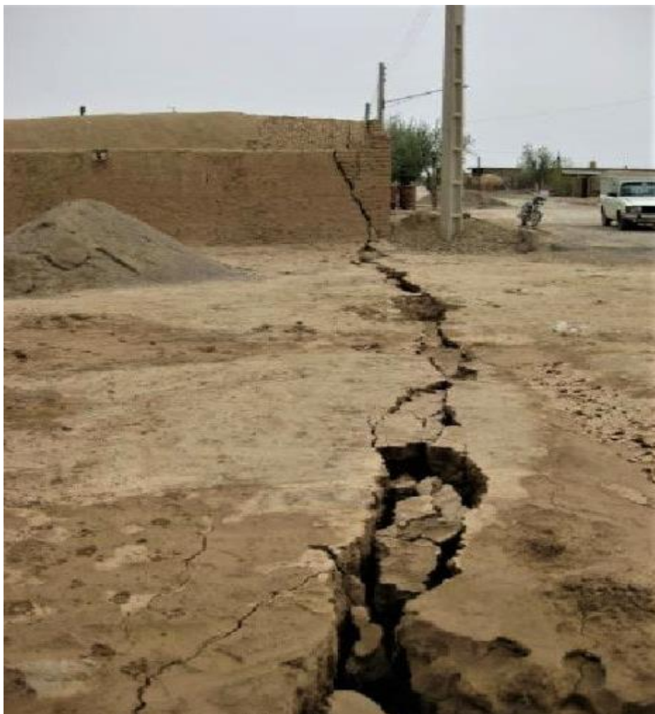
شکل (۲-۱۲) شکاف بلند و پهنی که در پی فرونشست زمین در قسمت جنوبی دشت دامغان ایجاد شده است [۱۹]
