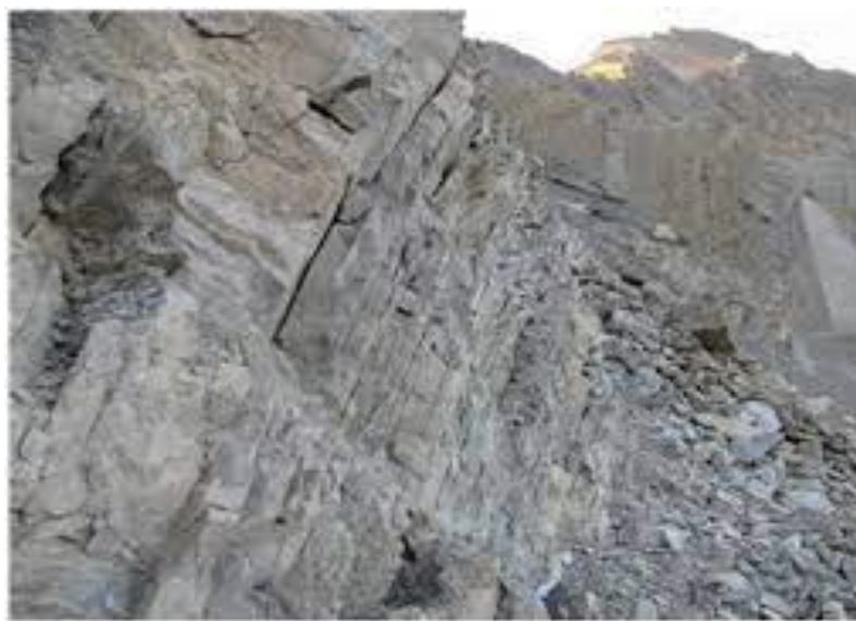
شکل (۲-۱۰) شکست واژگونی در خروجی تونل انحراف آب سد مشمپای زنجان [۱۵]
