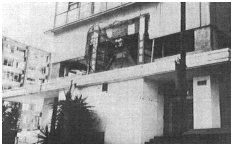
شکل (۲-۲۵) - شمایی از نمای خارجی ساختمان مقاوم شده تأمین اجتماعی مکزیک با استفاده از مهاربند- میراگر
