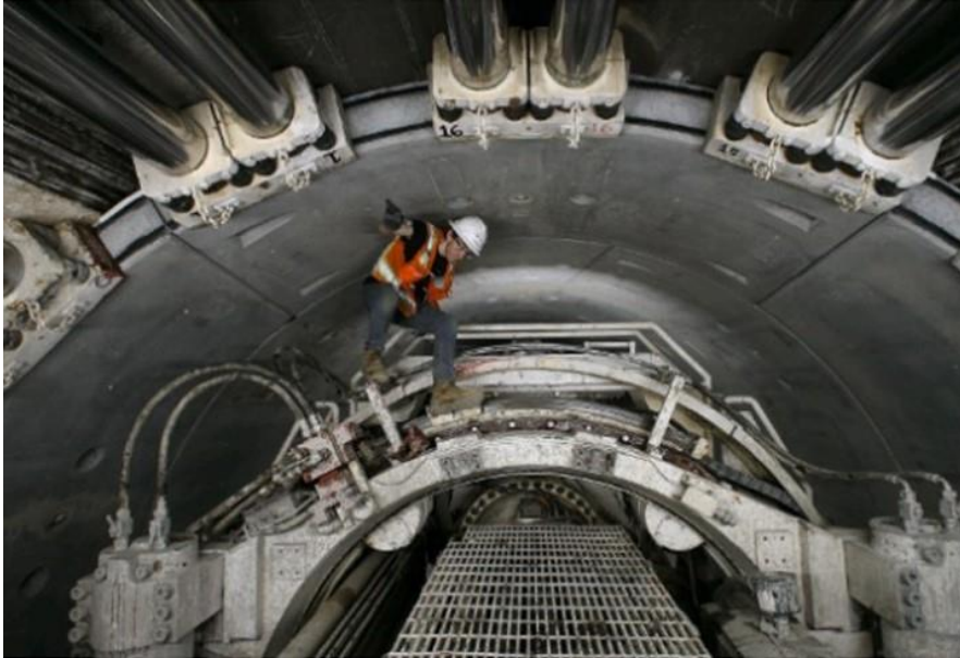
شکل ۱-۳: نصب سگمنت توسط TBM [۱۰]
