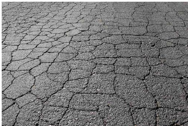
شکل ۱-۲. ترک خوردگی خستگی
