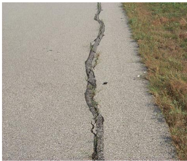
شکل ۲-۶. ترک خوردگی لبه
