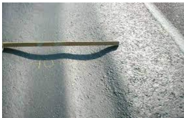
شکل ۷-۲. شیارشدگی
