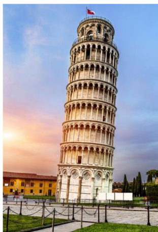
شکل (۱-۱) برج پیزا، رخ دادن نشست به علت عدم بهسازی خاک بستر
