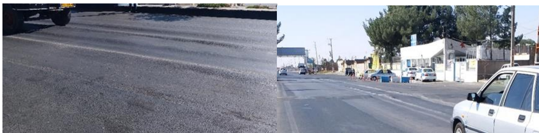
شکل ۴-۱۹. کیفیت پایین روسازی در محل پلیس راه با وجود سن کم روکش
