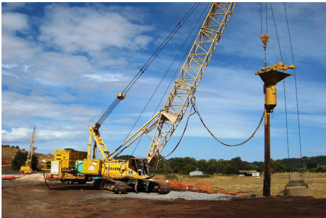
شکل (۲-۲) استفاده از ستون شنی در بزرگراه pacific [۱۳]
