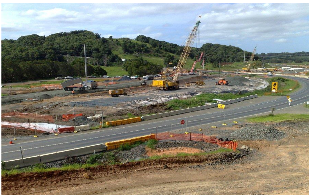
شکل (۳-۲) استفاده از ستون شنی در بزرگراه pacific [۱۳]
