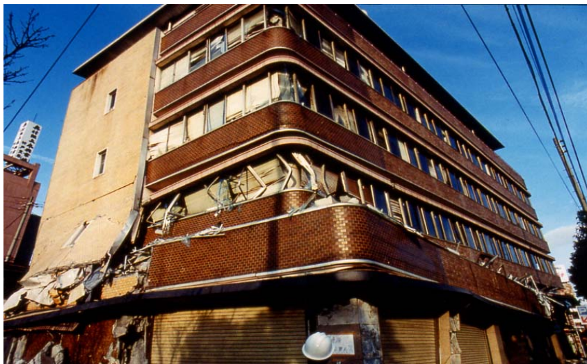
شکل ۱-۱۷ شکست برشی به دلیل عدم در نظر گرفتن اثر دیوار پرکننده (کوبه، ۱۹۹۵)
