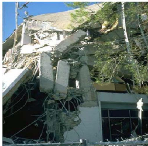
شکل ۳-۴ گسیختگی متناظر با فروریزش اتصال تیر-ستون
