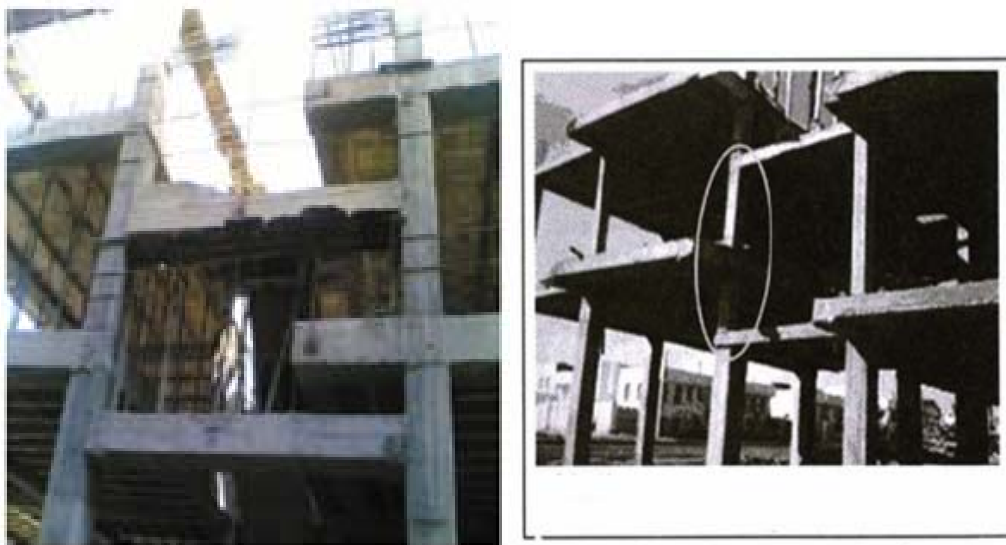
شکل ۱-۲۲ ستون کوتاه به علت هندسه ی معماری و وجود دیوارها
