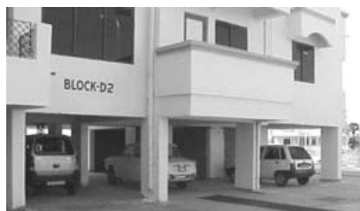
شکل ۱-۱۱ پتانسیل ایجاد طبقه‌ی نرم به علت فقدان دیوارهای پرکننده
