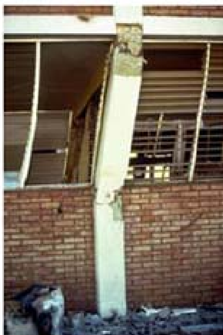
شکل ۲۱-۱ شکست خمشی ستون کوتاه
