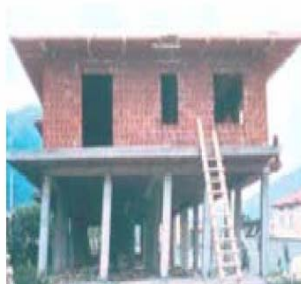
شکل ۱-۱۲ ایجاد مکانیزم طبقه در ساختمان در حال احداث و آستانه‌ی فرو ریزش (ایتالیا ۱۹۷۶)
