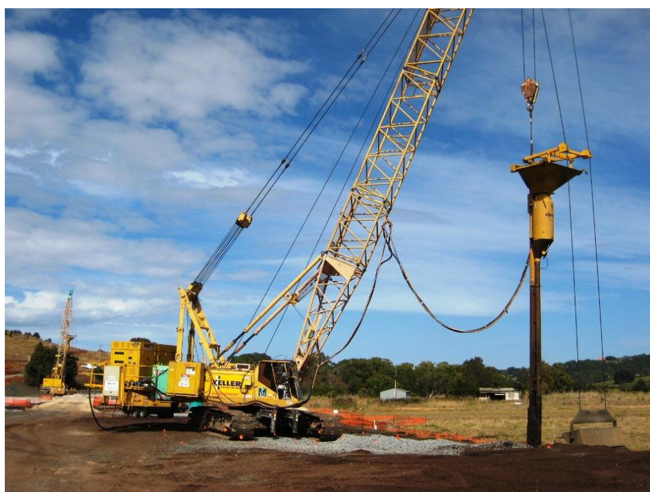
شکل (۲-۲) استفاده از ستون شنی در بزرگراه pacific [۲۶]
