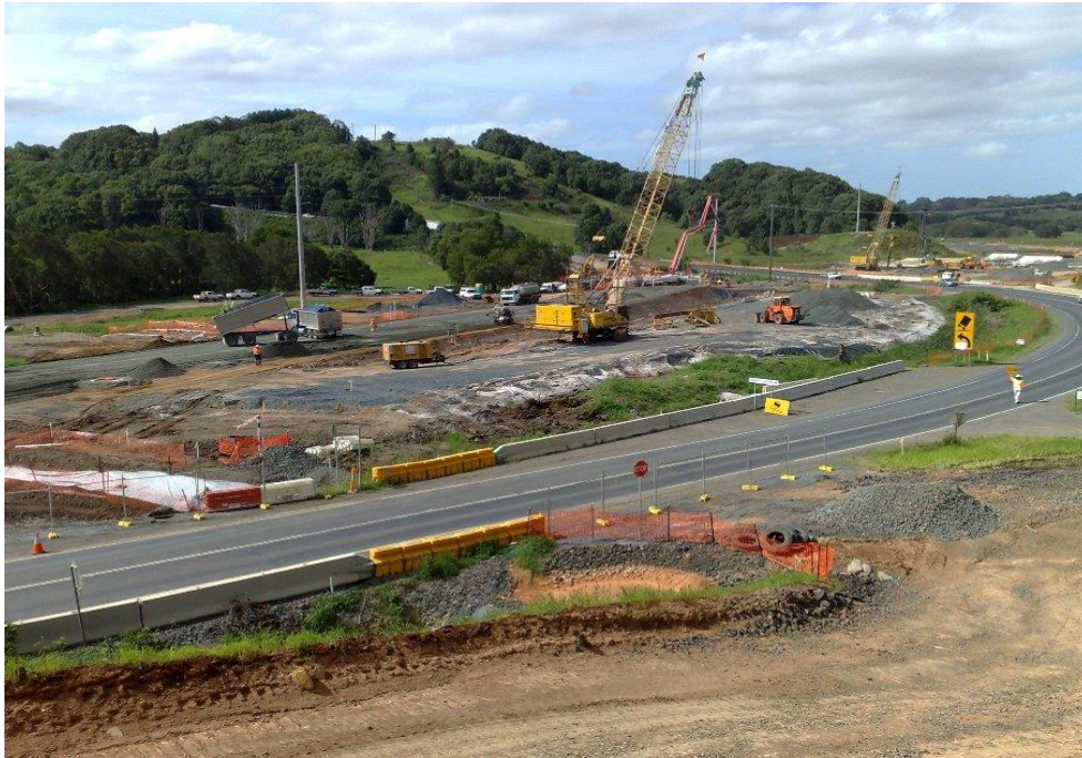
شکل (۳-۲) استفاده از ستون شنی در بزرگراه Pacific [۲۶]
