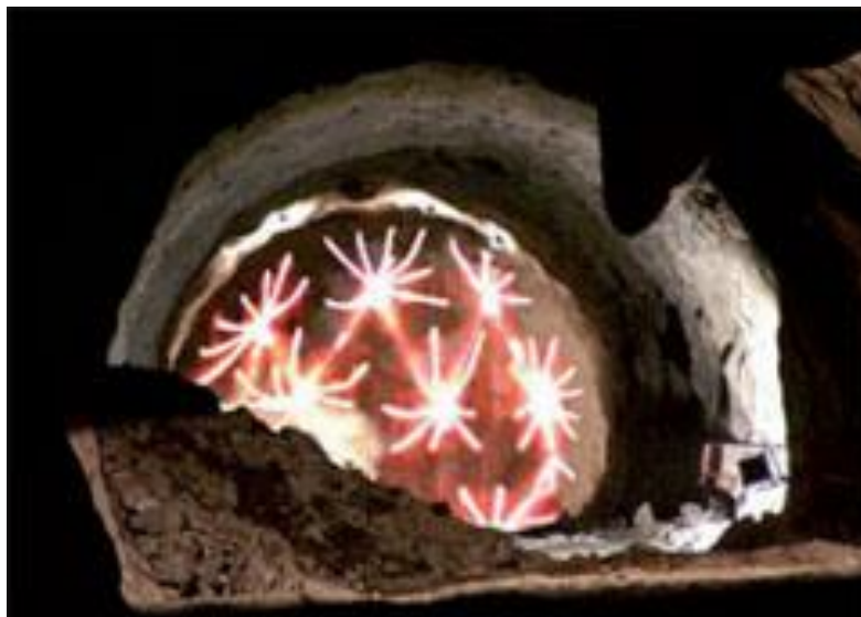
شکل ۲-۱۳ انفجار حفاری در سینه‌ی کار تونل.
