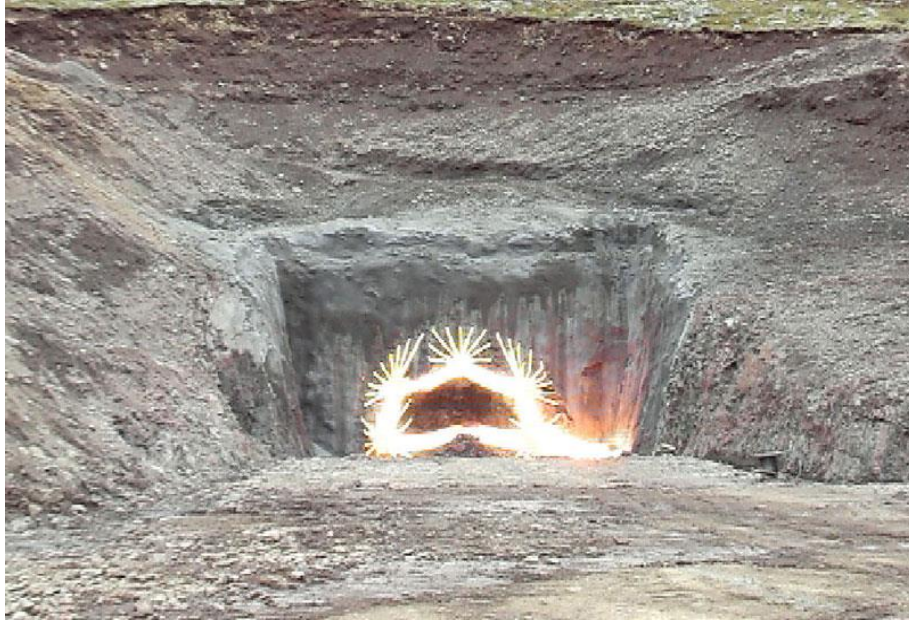
شکل ۲-۱۱ انفجار در سینه‌ی کار تونل.
