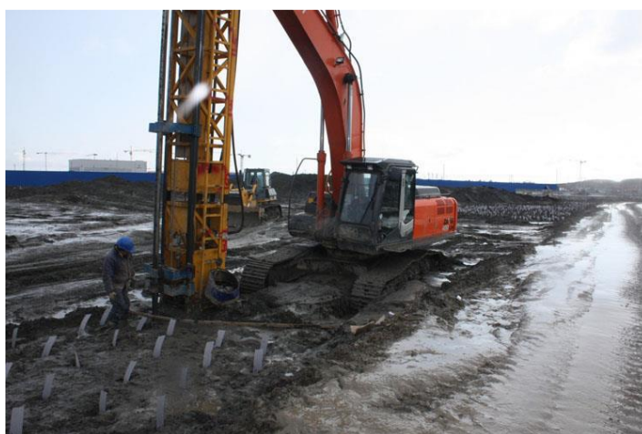
شکل ۲-۳ اجرای فیلترهای تخلیه اضافه آب منفذی
