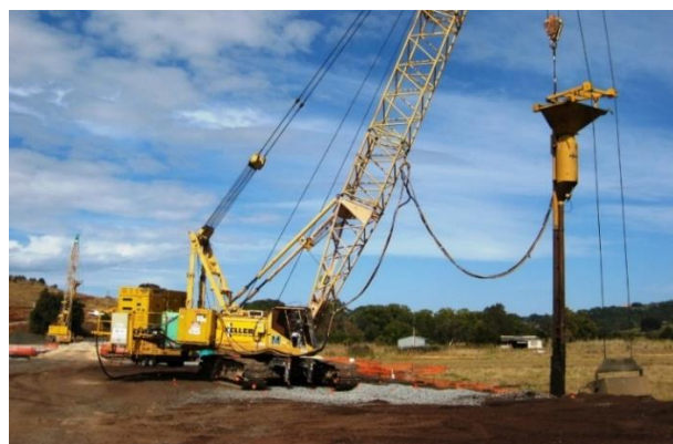
شکل ۲-۲ اجرای ستون سنگی
