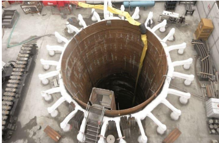
شکل ۲-۴ بهسازی فیزیکی به روش انجماد خاک
