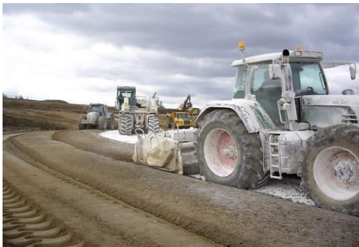
شکل ۲-۵ بهسازی شیمیایی خاک به‌وسیله آهک
