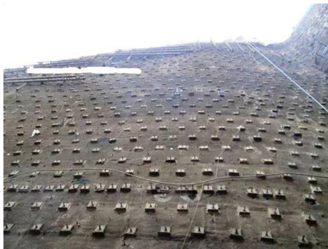
شکل ۶-۲ نمای از اجرای نیلینگ
