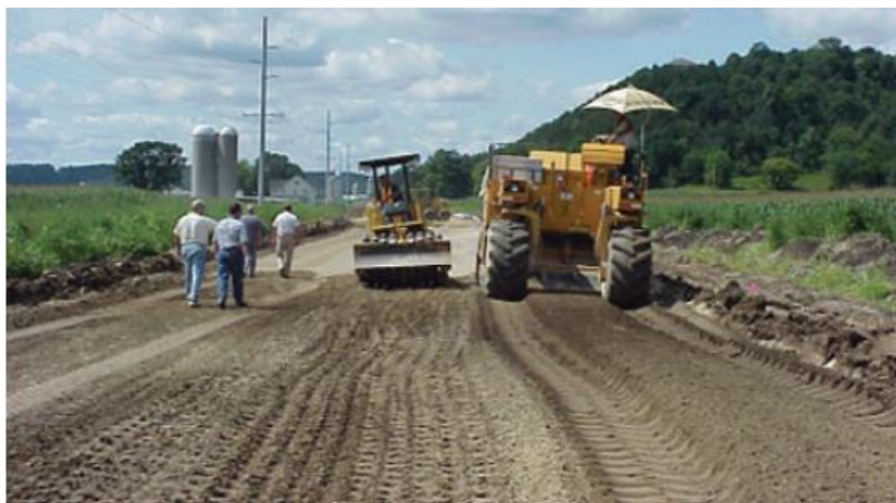
شکل ۲-۱۷ تثبیت خاک با استفاده از خاکستر بادی [۸]
