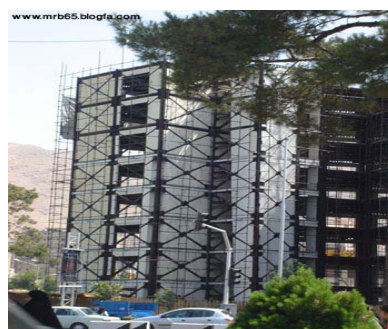
شکل ۴-۱- ساختمان با سیستم مختلط اسکلت فلزی و 3D پانل
