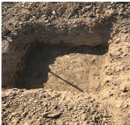
شکل (۸-۳) کف سازی محل قرارگیری تشت‌ها
