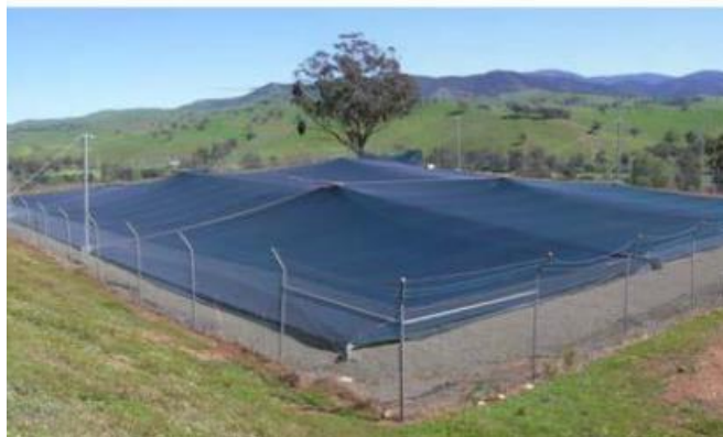
شکل (۴-۲) نمونه‌ای از پوشش سایه‌انداز به منظور کاهش تبخیر
