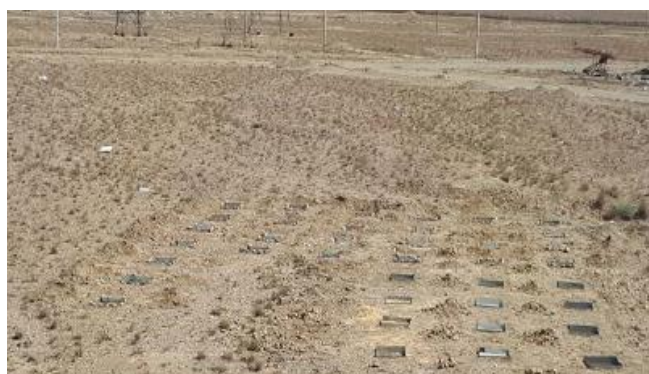
شکل (۶-۳) گودال‌های حفاری شده
