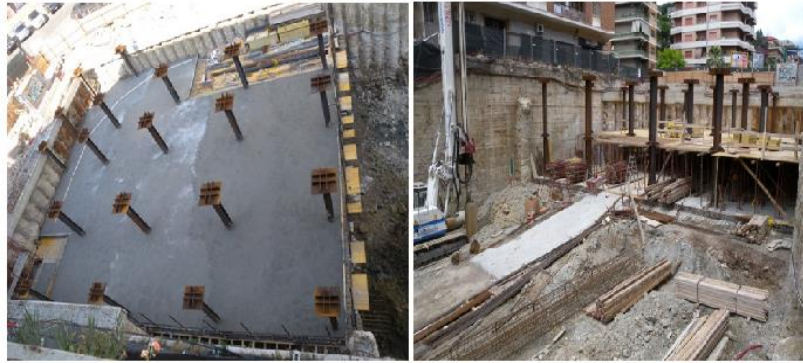
شکل ۲-۱۳. نمونه‌ای از روش ساخت بالا به پایین [۵]
