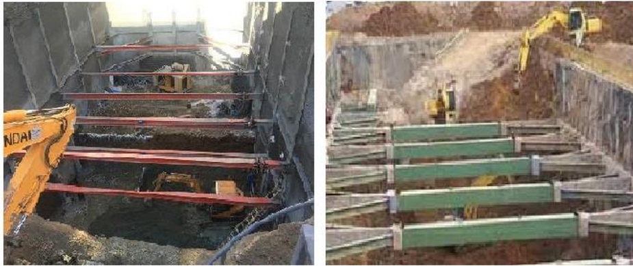
شکل ۲-۸. نمونه‌هایی از پایدارسازی گود با روش مهار متقابل [۵]
