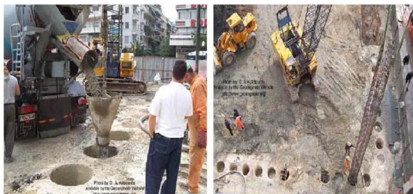
شکل ۲-۱۵. نمایش قسمتی از عملیات اجرای شمع [۵]
