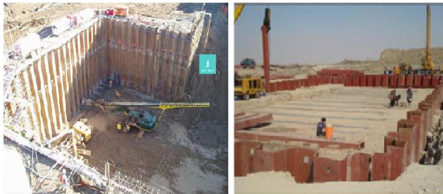
شکل ۲-۱۲. پایدارسازی گودبرداری با روش سپرکوبی [۸]
