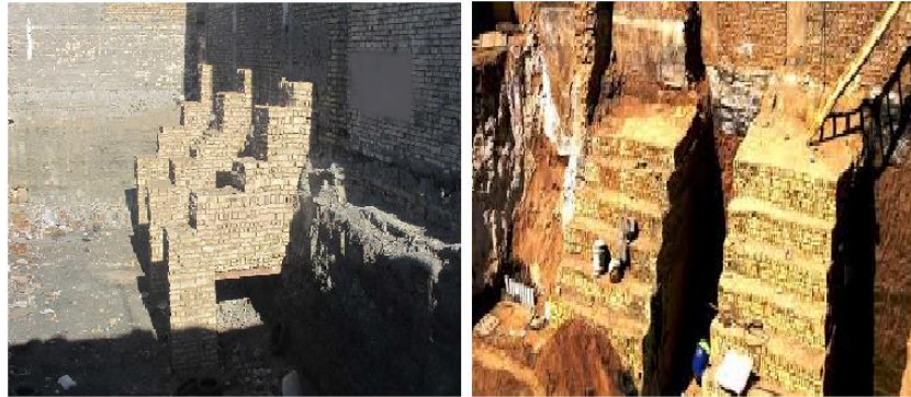
شکل ۲-۳. اجرای سازه نگهدار دیواره وزنی آجری
