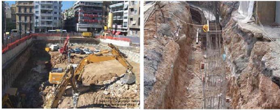
شکل ۲-۱۷. مراحل اجرای تیر رابط و گودبرداری [۱۱]
