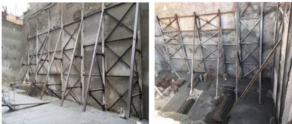
شکل ۲-۵. پایدارسازی گودبرداری با روش خرابایی [۵]
