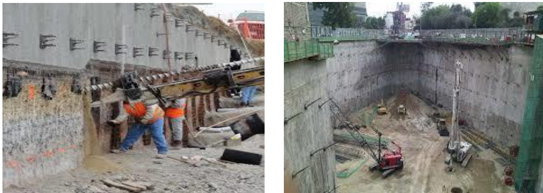
شکل ۲-۶. دیوارهای حائل میخ‌کوبی شده [۵]
