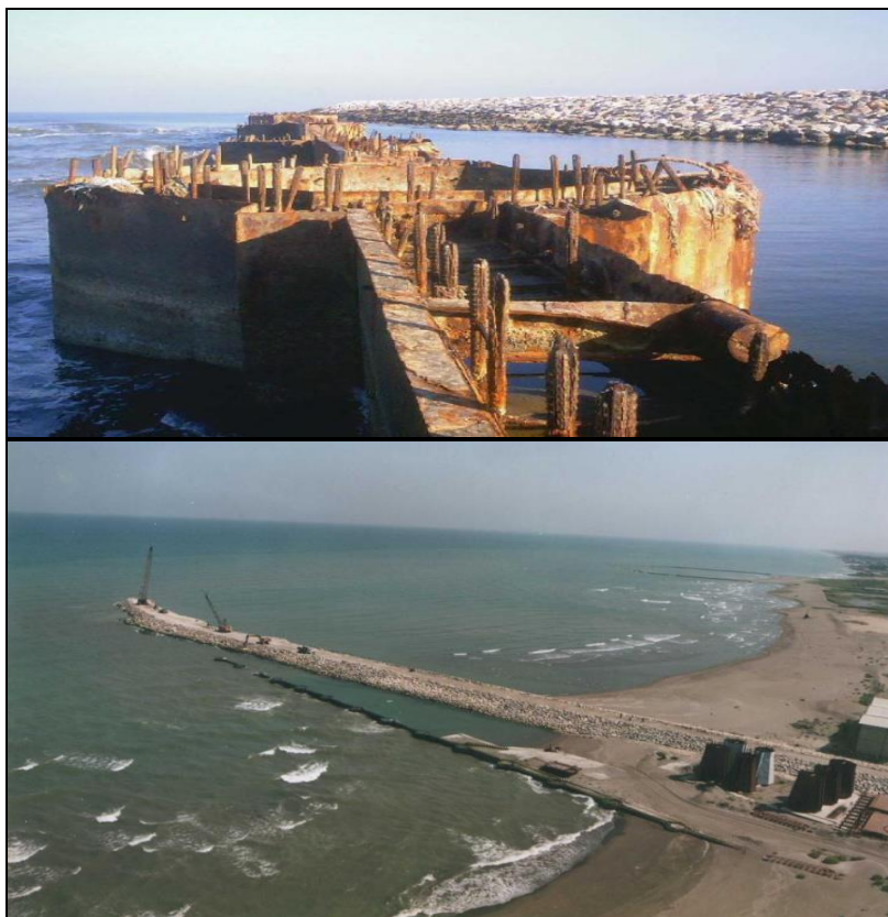
شکل ۴-۶ تصاویری از طرح موجشکن کیسونی نیمه‌رها شده در کنار موجشکن توده سنگی در حال اجرا [۷۷].
