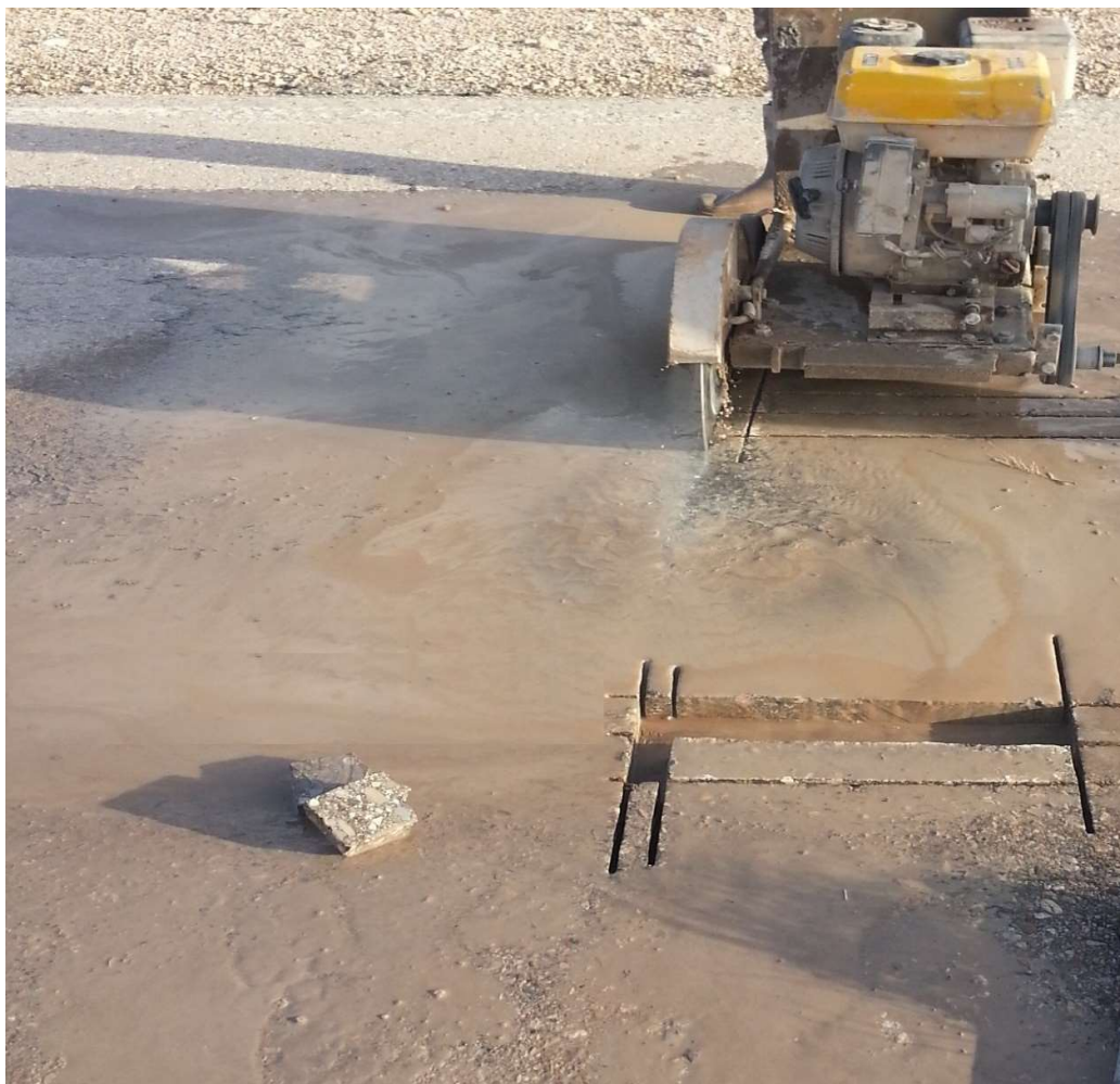
شکل (۷-۳) خارج کردن دال‌های آسفالتی از سطح روسازی
