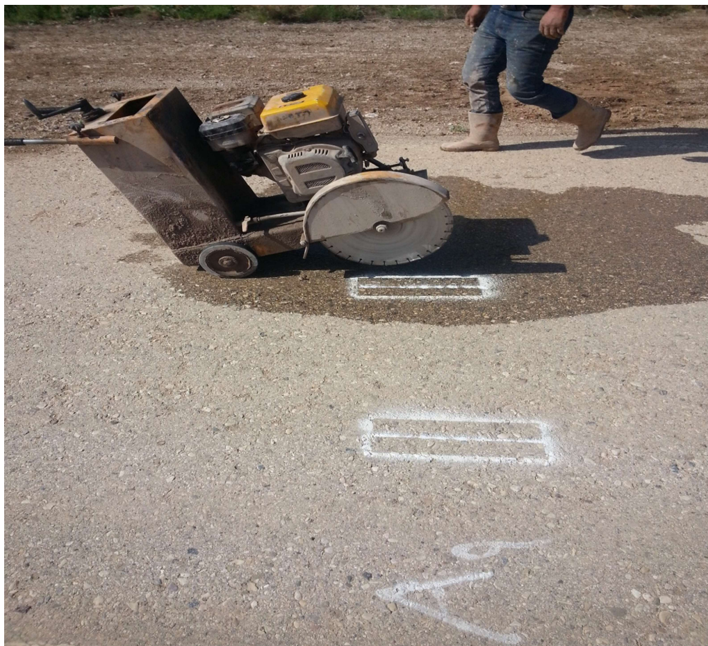
شکل (۳-۶) دستگاه کاتر مخصوص برش آسفالت
