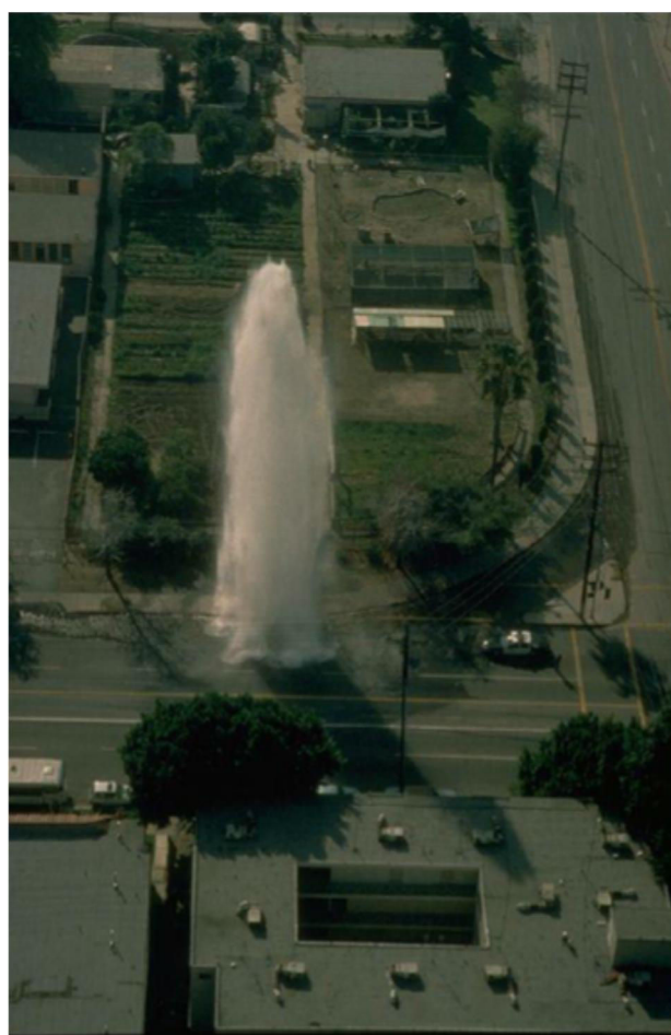
شکل (۴-۱): فوران آب ناشی از شکست لوله آب در زلزله ۱۹۹۴ نورتریج
