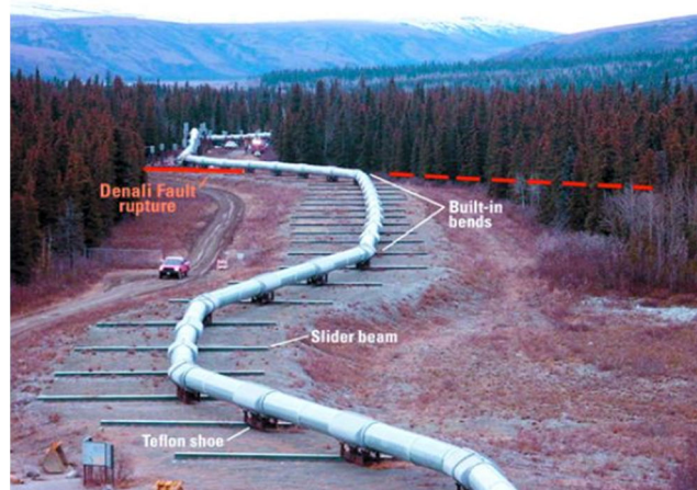
شکل (۴-۲): خط لوله روزمینی با اتصالات انعطاف‌پذیر
