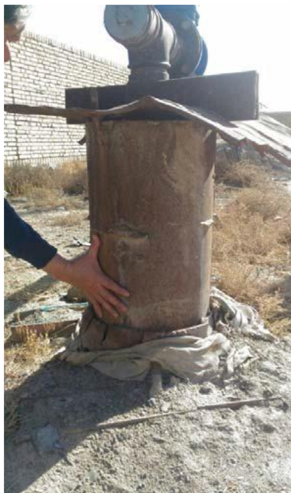
شکل ۴-۴۰: نمونه‌ای از لوله‌زایی ایجادشده در روستای کلاته برفی
