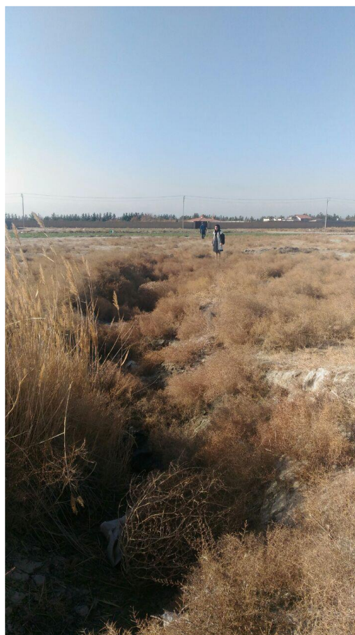
شکل ۲-۵: شکاف به وجود آمده ناشی از پدیده فرونشست در منطقه کلاته برفی دشت مشهد
