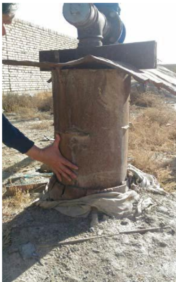
شکل ۲-۸: نمونه‌ای از لوله‌زایی ایجادشده در روستای کلاته برفی
