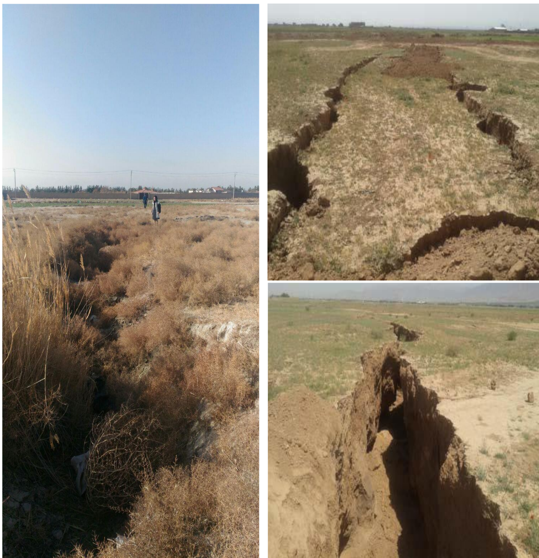
شکل ۴-۳۹: شکاف بوجود آمده ناشی از پدیده فرونشست در منطقه کلاته برفی دشت مشهد
