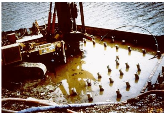
شکل (۱-۱) ریزشمع‌های استفاده شده زیر تکیه گاه‌های پل نهر "ماهونینگ" در استان آرمسترانگ [۱]
