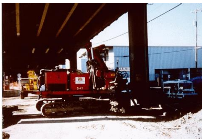
شکل (۲-۱) تقویت پی پل بتنی خیابان امرسون غربی در سیاتل، واشینگتن [۱]
