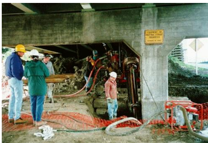
شکل (۳-۱) نصب و اجرای ریزشمع‌ها در ارتفاع سقف کم [۱]
