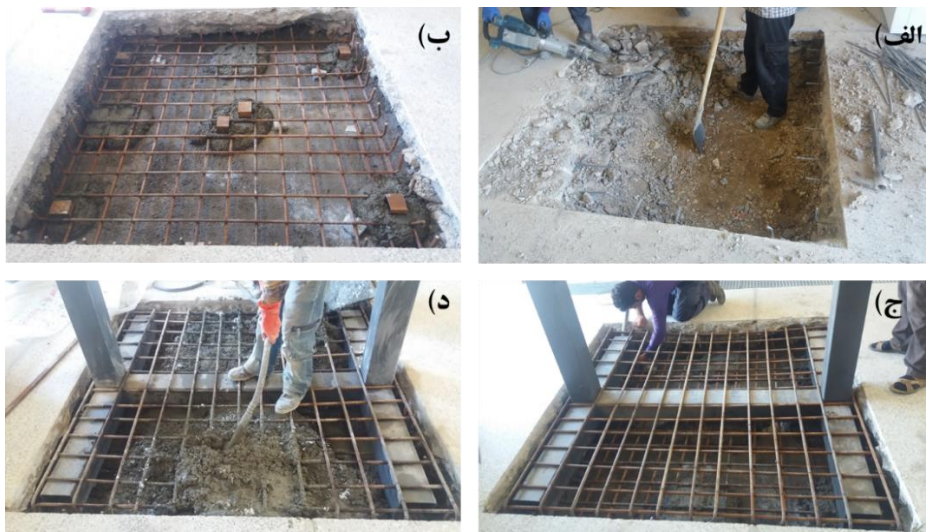
شکل (۱۶-۳) روند ساخت فونداسیون دستگاه
