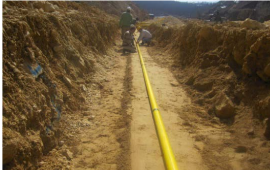
شکل (۳-۱۲) لوله های انحراف سنج افقی
