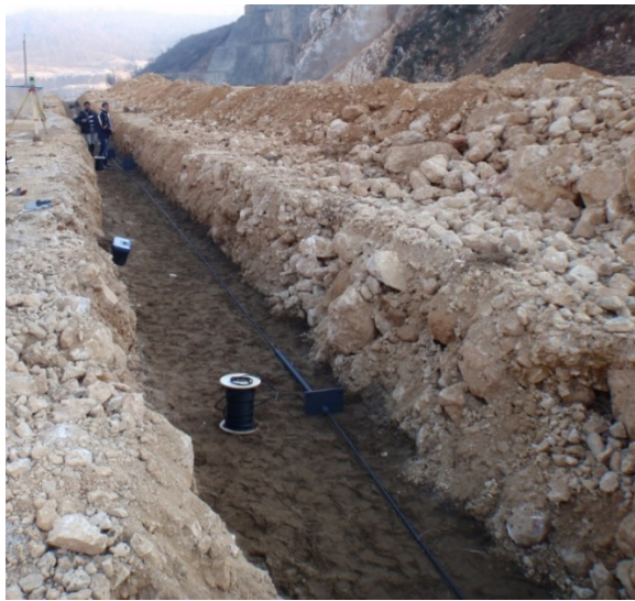
شکل (۳-۱۰) سری کشیدگی سنج افقی زنجیره ای و متعلقات مربوطه
