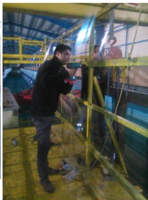
شکل (۳-۱۷) : نمایی از مراحل ساخت و جوشکاری قاب فولادی برای دیواره شفاف بر روی زیرسازه
