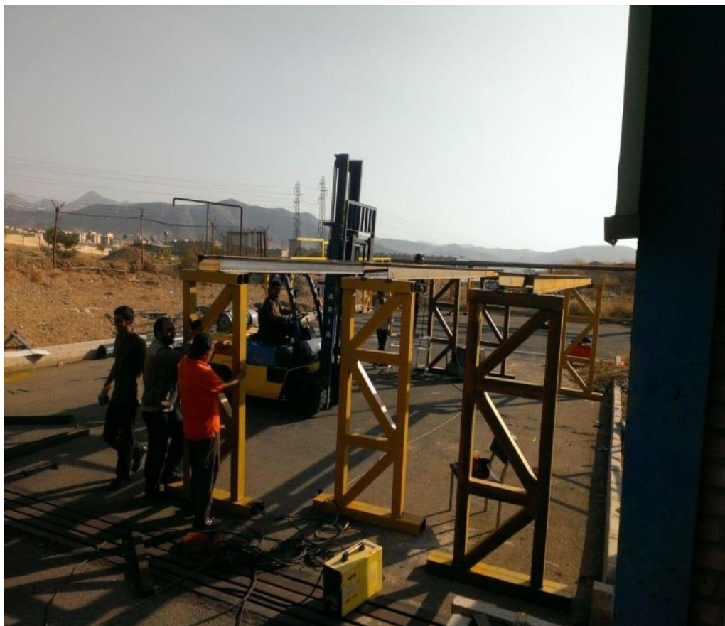
شکل (۱۱-۳) : رنگ آمیزی پل های فلوم ثانویه
