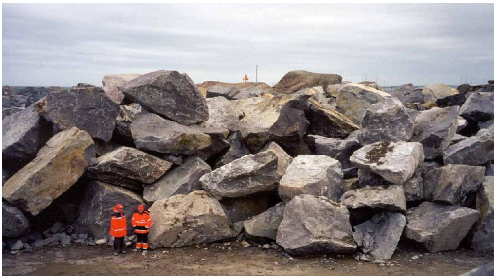
شکل (۴-۲): نمایی از سنگ های کلاس ۱ موج شکن سکویی چندلایه (ایسلندی)
