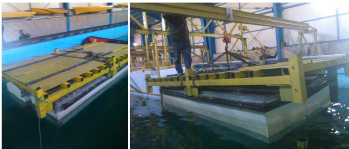
شکل (۳-۱۶): نمایی از نحوه انتقال طبقه متحرک زیرسازه به وسیله پانتون و نصب آن بر روی زیرسازه
