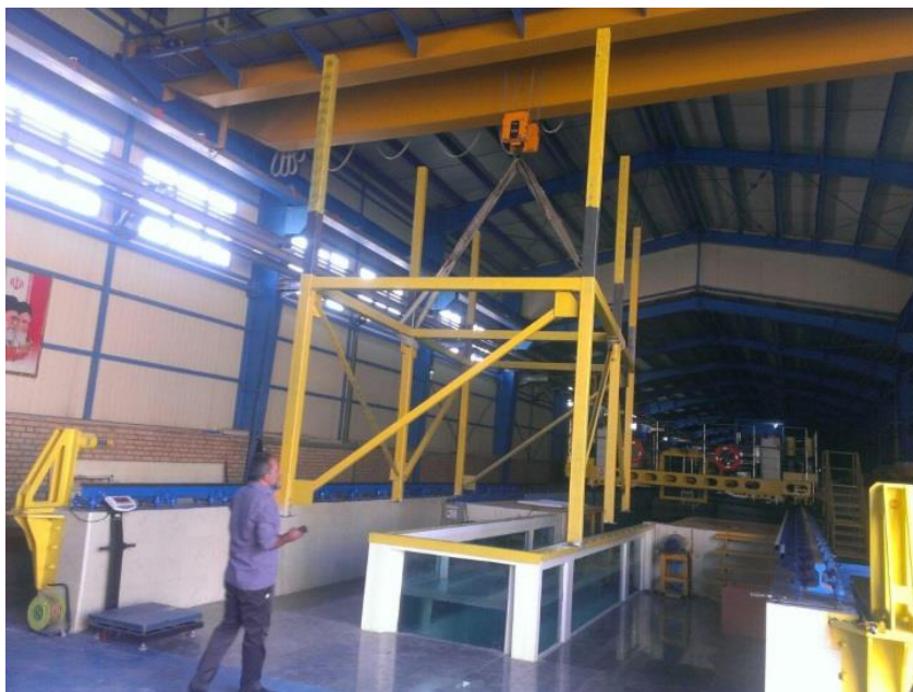
شکل (۳-۱۵): انتقال زیرسازه توسط جرثقیل به داخل فلوم اصلی
