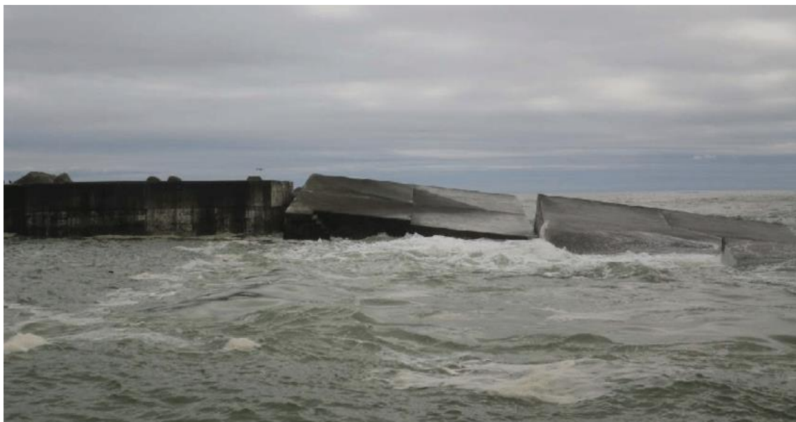
شکل (۴-۱): تخریب موج شکن کیسونی بعد از وقوع سونامی
