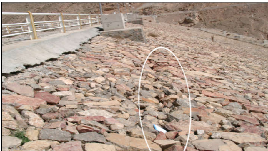
شکل (۳-۲۲) محدوده ترک خوردگی در شیب پایین دست
