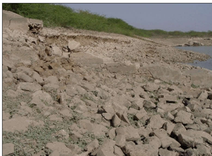
شکل (۷-۲) لغزش شیب بالا دست به داخل مخزن
