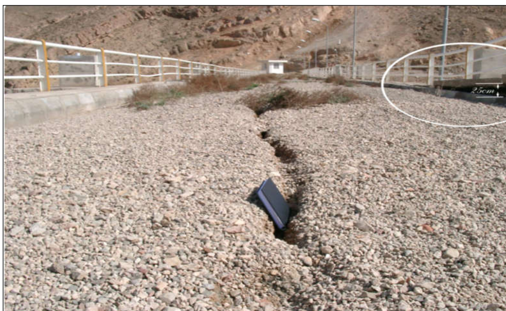
شکل (۲۵-۳) محدوده بالآمدگی تخته‌های بتنی روی تاج
