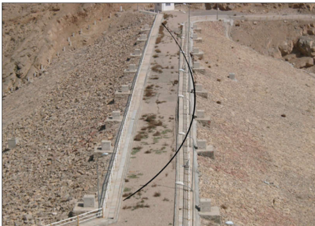
شکل (۳-۵۲) موقعیت قوس های لغزش در نقاط مختلف و تجميع خروجی آنها در یک نقطه در محل TR
