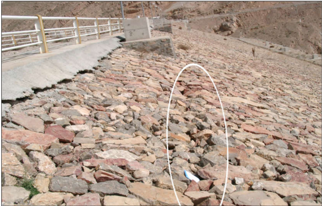
شکل (۵۰-۳) موقعیت قوس لغزش روی شیب پائین دست در محل TR1 با شعاع R3
