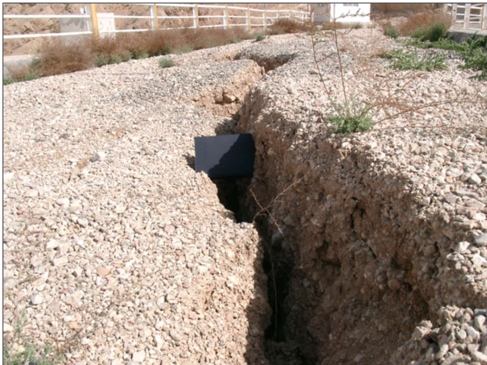
شکل (۳-۴۶) موقعیت قوس لغزش روی محور سد در محل TR1 با شعاع R1
