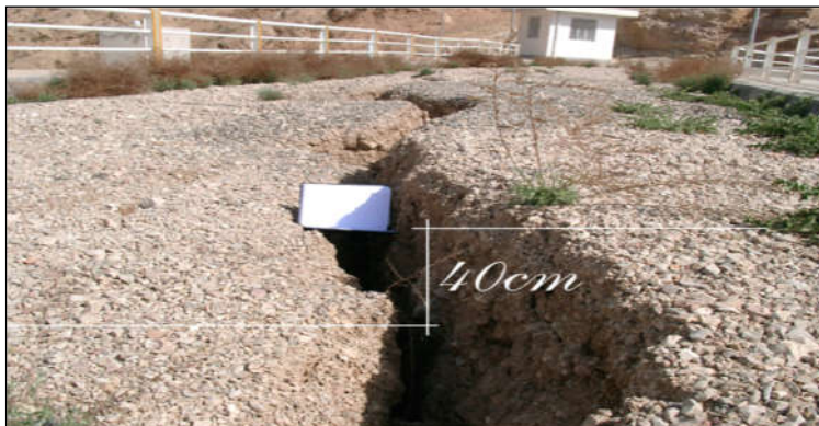
شکل (۳-۲۷) نشست موضعی تاج سد به شکل پلکان با جابجایی همزمان به سمت بالادست
