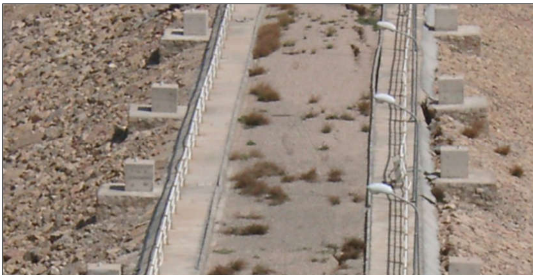
شکل (۳-۳۱) عریض شدن تاج سد در اثر تغییر شکل‌های افقی در بخش میانی تاج
