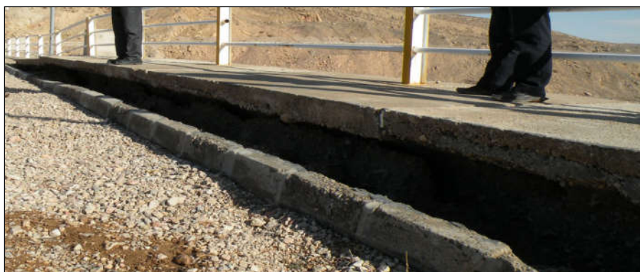
شکل (۳-۲۹) جدا شدن جدول روی تاج سد از تخته‌های بتنی پیاده رو از اثر تنش‌های فشاری
