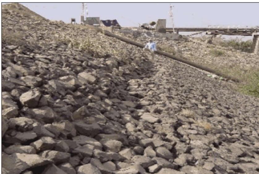
شکل (۶-۲) قوس خوردگی به داخل بدنه در شیب بالادست
