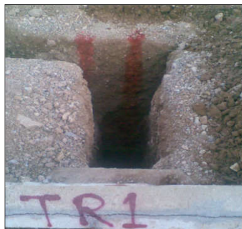
شکل (۳-۳۳) الف: حفر ترانشه در محل TR1
