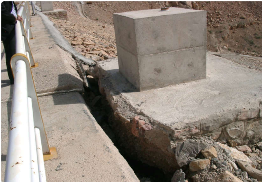
شکل (۳-۴۸) موقعیت قوس لغزش در حد فاصل تاج و شیب پائین دست در محل TR1 با شعاع R2
