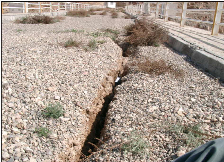
شکل (۳-۲۳) محدوده ترک خوردگی روی تاج به شکل خط مستقیم
