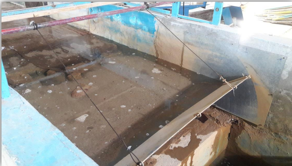
شکل ۳-۵: نمایی از سرریز بادبزی در انتهای کانال
