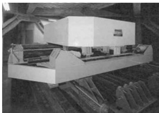
شکل ۲-۹ نمایی از برج چپا و میراگر جرمی بکار رفته در این برج
