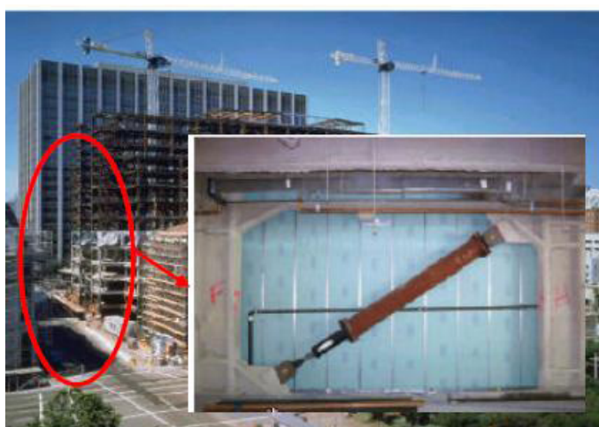
شکل (2-31): استفاده از میراگر ویسکوز بجای بادبند
