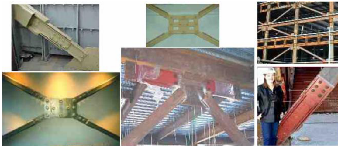
شکل (2-18): شکل های جدید میراگر اصطکاکی شرکت PALL
