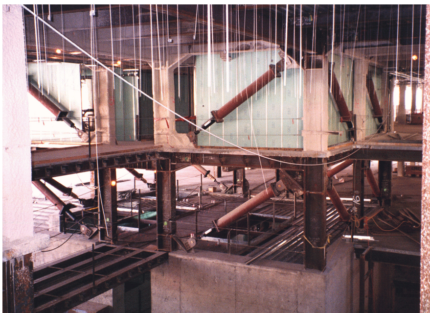
شکل (29-2): نصب میراگر در مرکز San Francisco Civic
