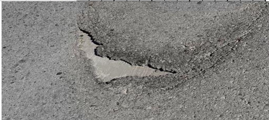
شکل ۴-۷- جدول گزارش خرابی به همراه تصویر چاله معادل آن
