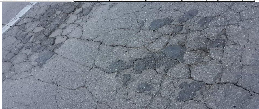
شکل ۴-۶- جدول گزارش خرابی به همراه تصویر ترک پوست سوسماری معادل آن
