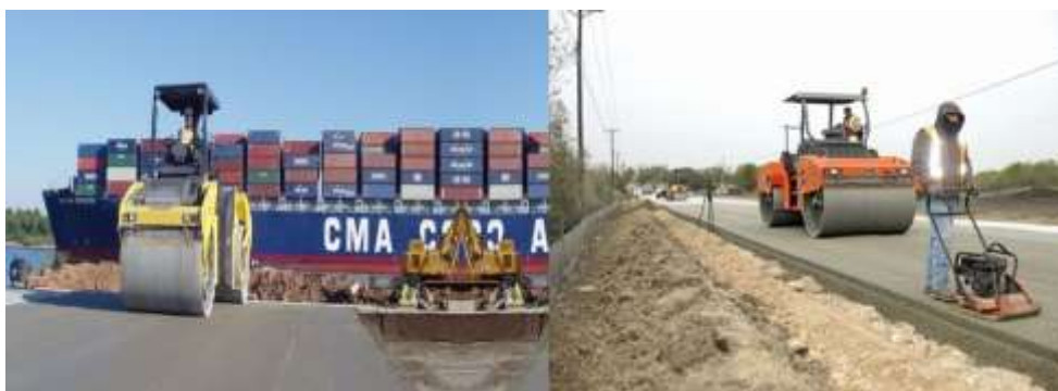
شکل ۱-۲ عملیات تراکم روسازی بتن غلتکی
