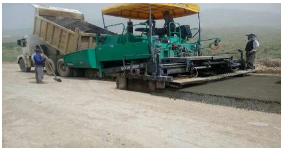
شکل ۱-۱ پخش روسازی بتن غلتکی به وسیله فینیشر
