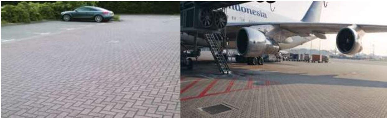
شکل ۷-۲ دو نمونه روسازی بتنی بلوکی
