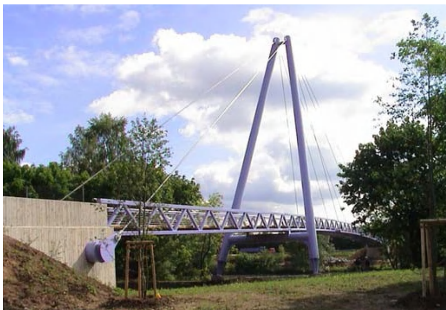
شکل ۲-۱۲: پل فرچهیم آلمان که با TMD درمودهای قائم نصب گردیده است. [۱۰]
