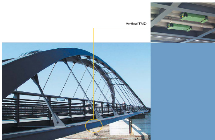
شکل ۱۰-۲ نمونه دیگری از TMD در پل اسشوت برلین آلمان [۹]
