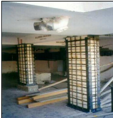
شکل ۰(۳-۹): ستون بتن مسلح مستطیلی مقاوم شده با ژاکت فولادی
