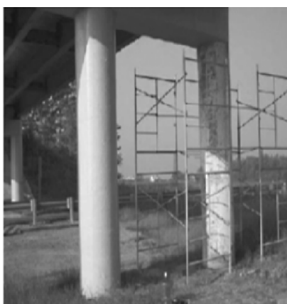
شکل (۳-۱۱): تمیز کردن ستون قبل از نصب ورقه ها- نصب FRP
