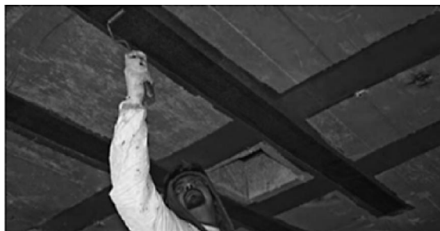
شکل (۳-۱۰): نصب صفحات CFRP به منظور مقاوم سازی خمشی تیر
