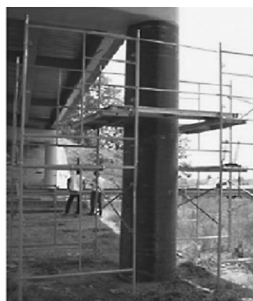
شکل (۳-۱۱): تمیز کردن ستون قبل از نصب ورقه ها- نصب FRP
