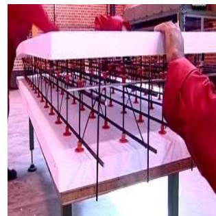
شکل (۲-۱۴) عملیات نصب پانل
