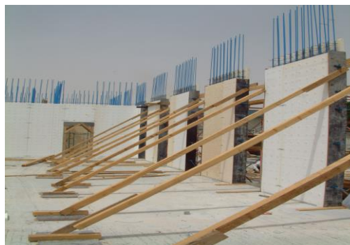
پانل های باربر بر روی فونداسیون
