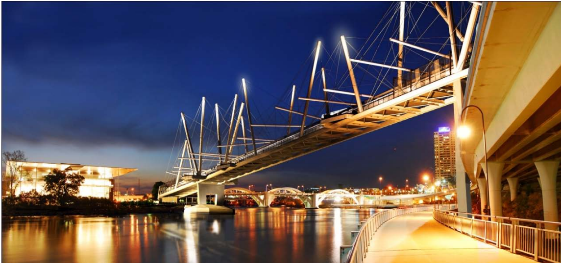
شکل ۵-۱: پل عابر پیاده کولپرا استرالیا [۷]
