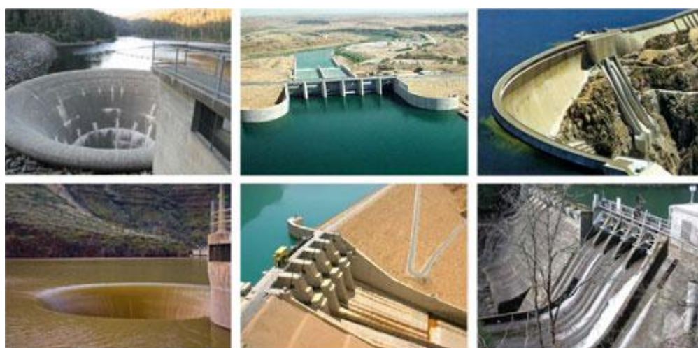
شکل ۱-۱ انواع سرریزها در سدهای بتنی و خاکی
