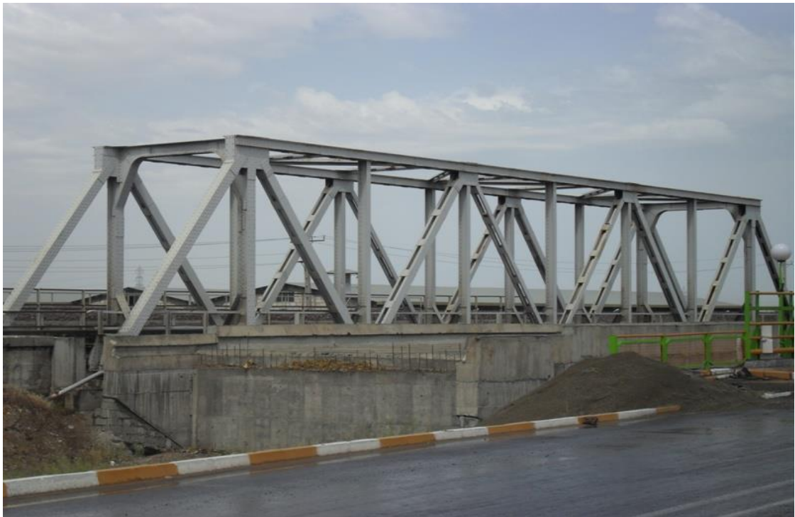
تصویر (۳-۴) تصویری از پل باقرآباد
