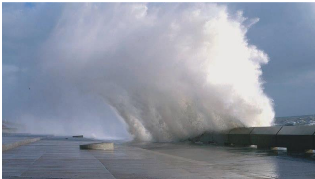
شکل ۴-۱: روگذری موج شدید در دیوار ساحلی samphire hoe در انگلیس
