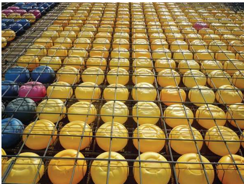
شکل ۲-۸- اجرای شبکه آرماتور بالایی
