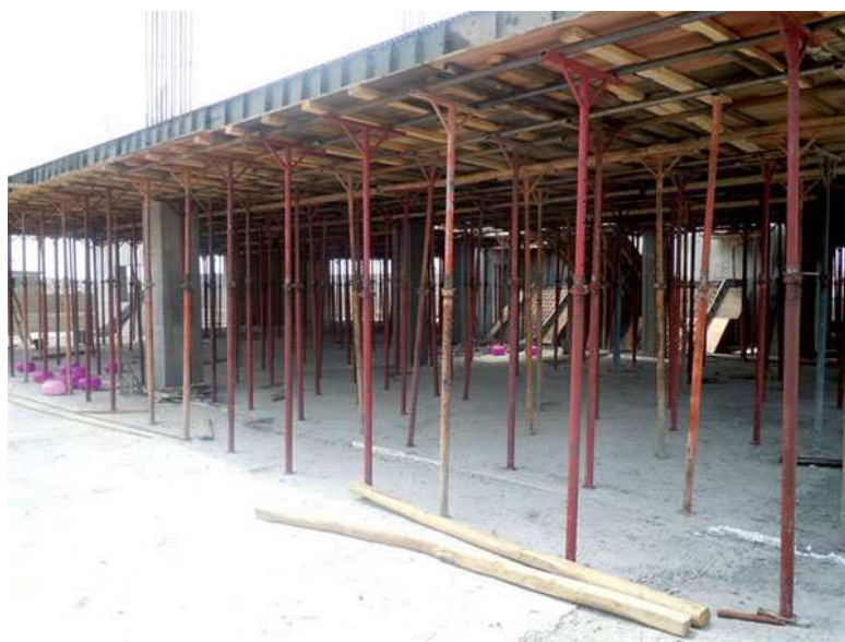
شکل ۲-۵- نحوه قالب بندی سقف کوبیاکس
