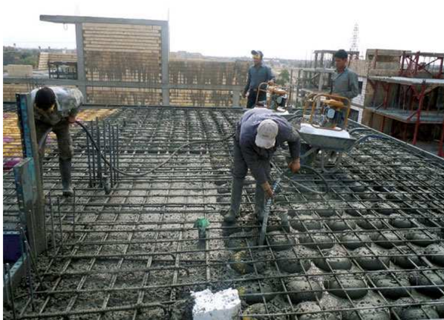
شکل ۲-۹- بتن ریزی و ویبره
