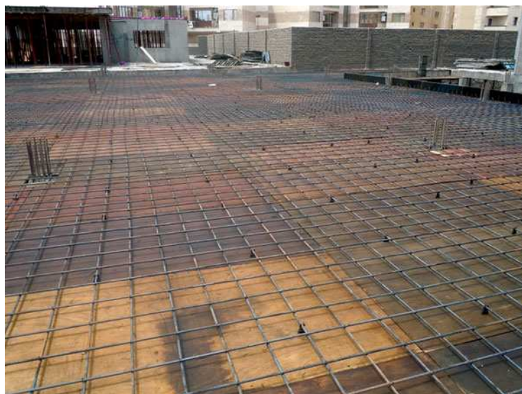
شکل ۲-۶- اجرای شبکه آرماتور پایینی
