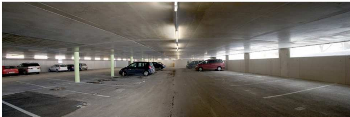
شکل ۳-۷- دال تخت کوبیاکس بادخانه ۱۶ متری (آلمان)
