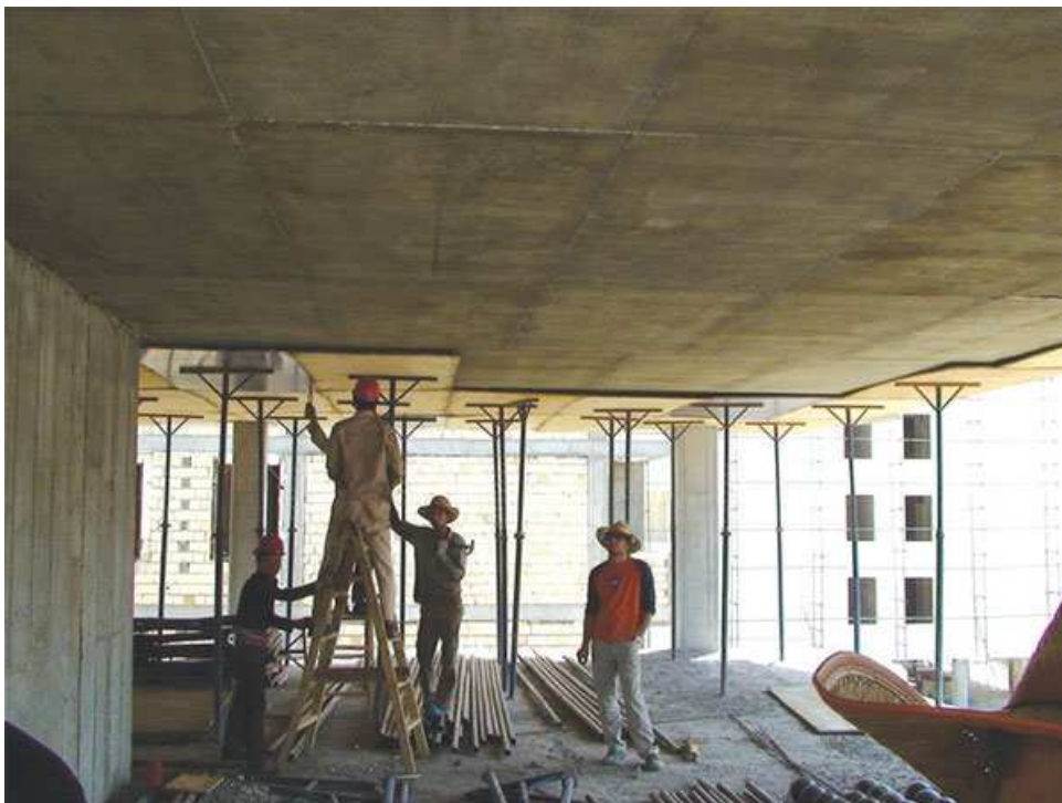
شکل ۲-۱۰- باز کردن قالب
