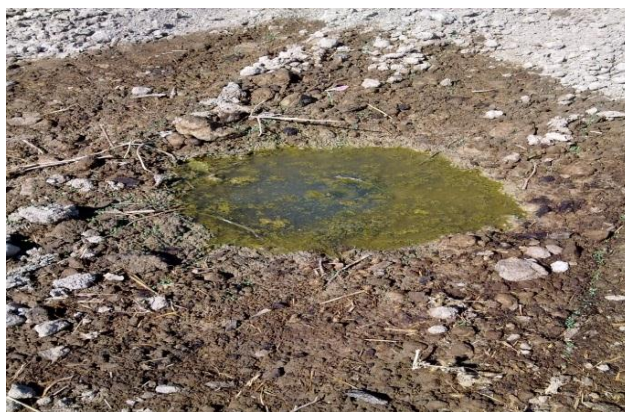
شکل ۴-۴۶- نشت آب از شیرخودکارها
