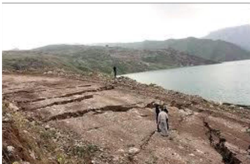
شکل ۵-۲- رانش مصالح بر اثر پدیده رگاب
