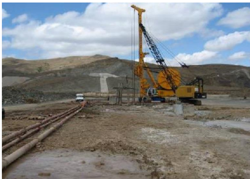
شکل ۲-۱۶- دستگاه هیدروفرز جهت حفاری دیوار آب بند (مهاب قدس، ۱۳۷۴)
