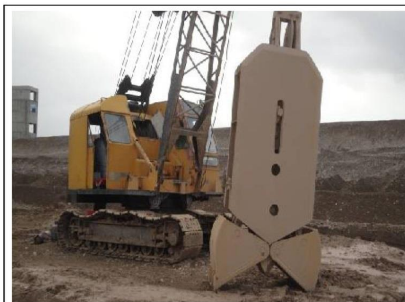
شکل ۱۷-۲- دستگاه کلمشل جهت حفار دیوار آببند (مهتاب قدس، ۱۳۷۴)
