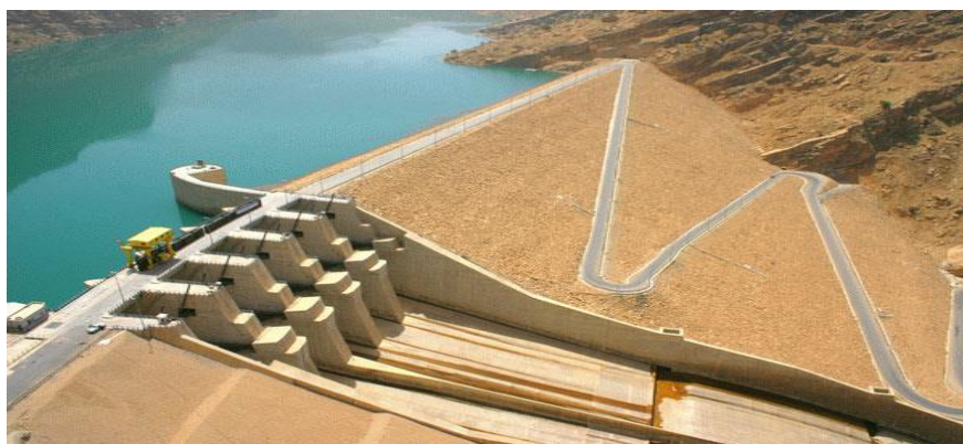
شکل ۲-۱- نمای کلی از سد خاکی
