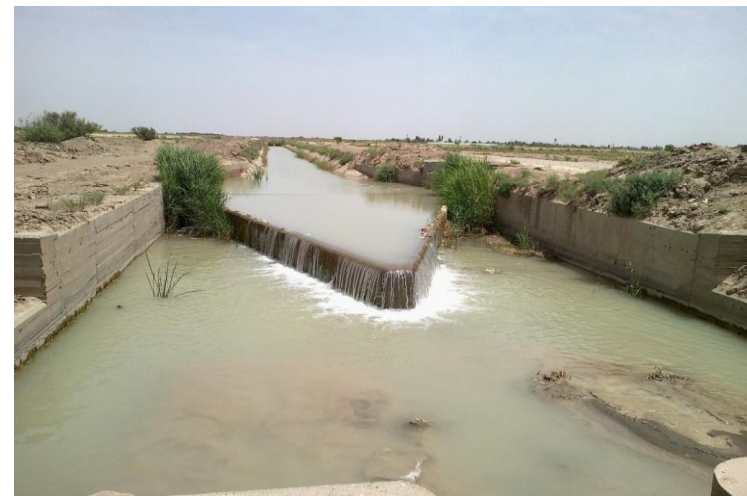
شکل ۴-۱۲- نمایش رسوب در کانال‌های شبکه‌ی گرمسار
