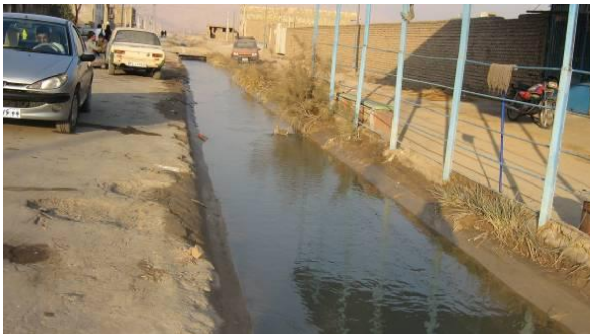
شکل ۴-۱۵- محل تقاطع کانال X۳ با بلوار راه آهن و برگشت آب در ورودی سیفون
