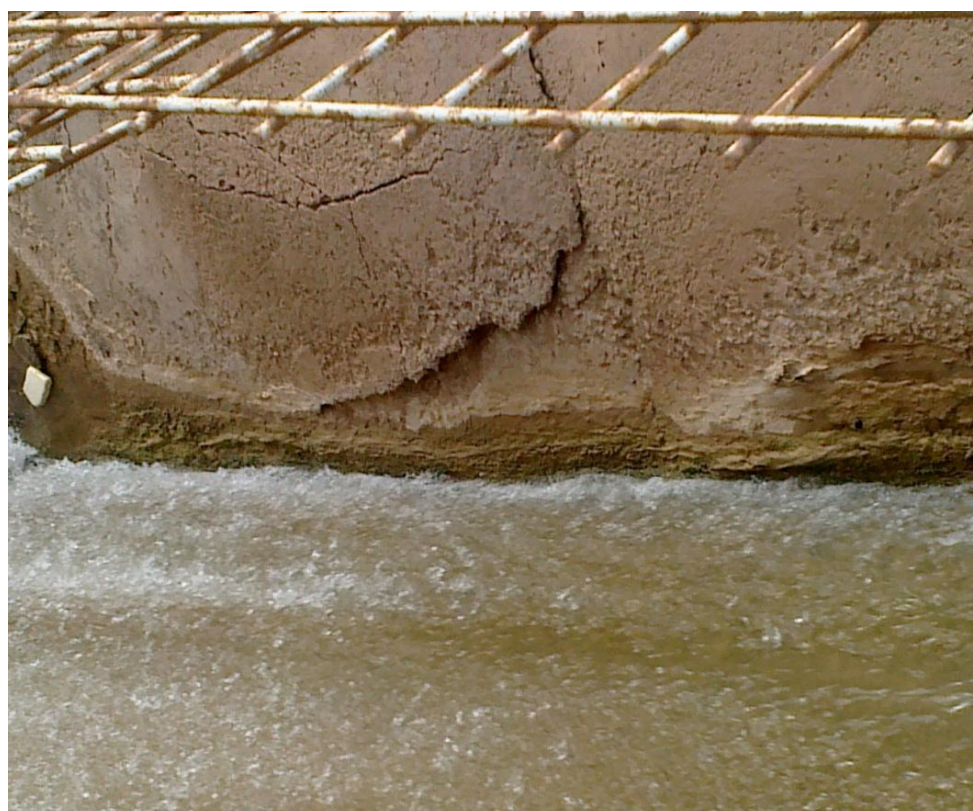
شکل ۴-۱۱- تخریب بتن در دراپ‌ها
