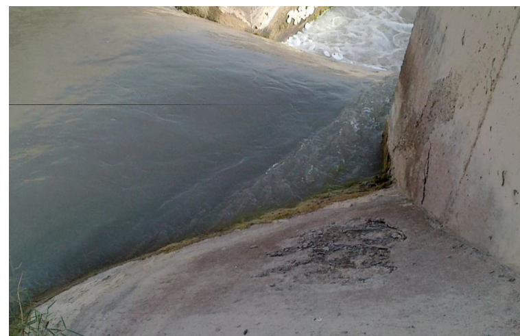
شکل ۴-۱۱- تخریب بتن در دراپ‌ها
