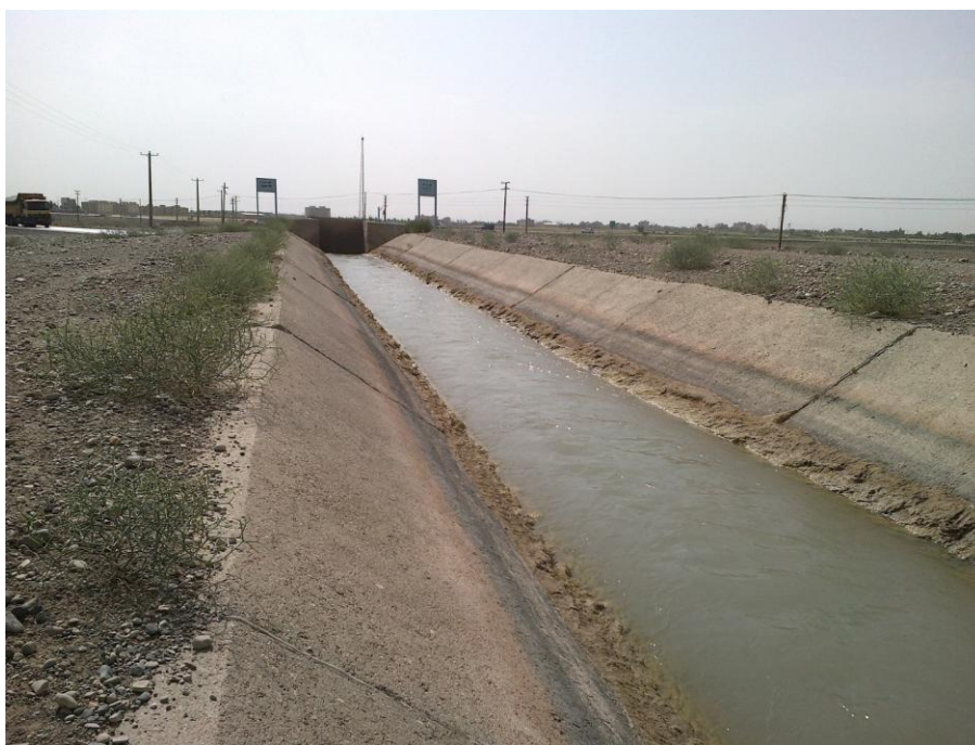
شکل ۴-۱- نمونه ی کانال انتقال پوشش دار شبکه ی گرمسار
