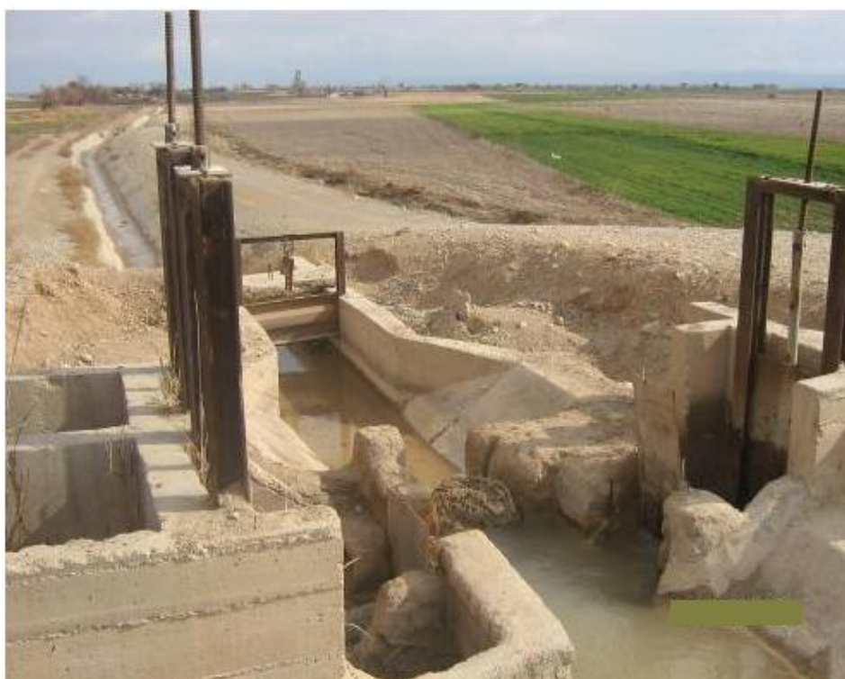
شکل ۴-۱۹- جعبه تقسیم و کانال درجه ۴ بلااستفاده برای اراضی کاظم‌بیگی
