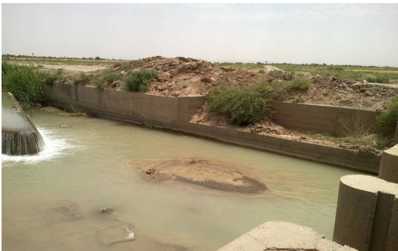
شکل ۴-۱۲- نمایش رسوب در کانال‌های شبکه‌ی گرمسار
