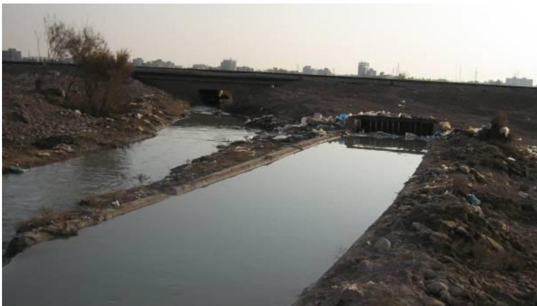
شکل ۴-۱۶- گرفتگی سیفون تقاطعی کانال X۳ با خط راه آهن و هدایت آب به زیر کالورت مجاور
