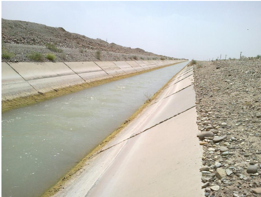
شکل ۲-۴- درزهای انقباض بصورت ناصحیح پر شده اند
