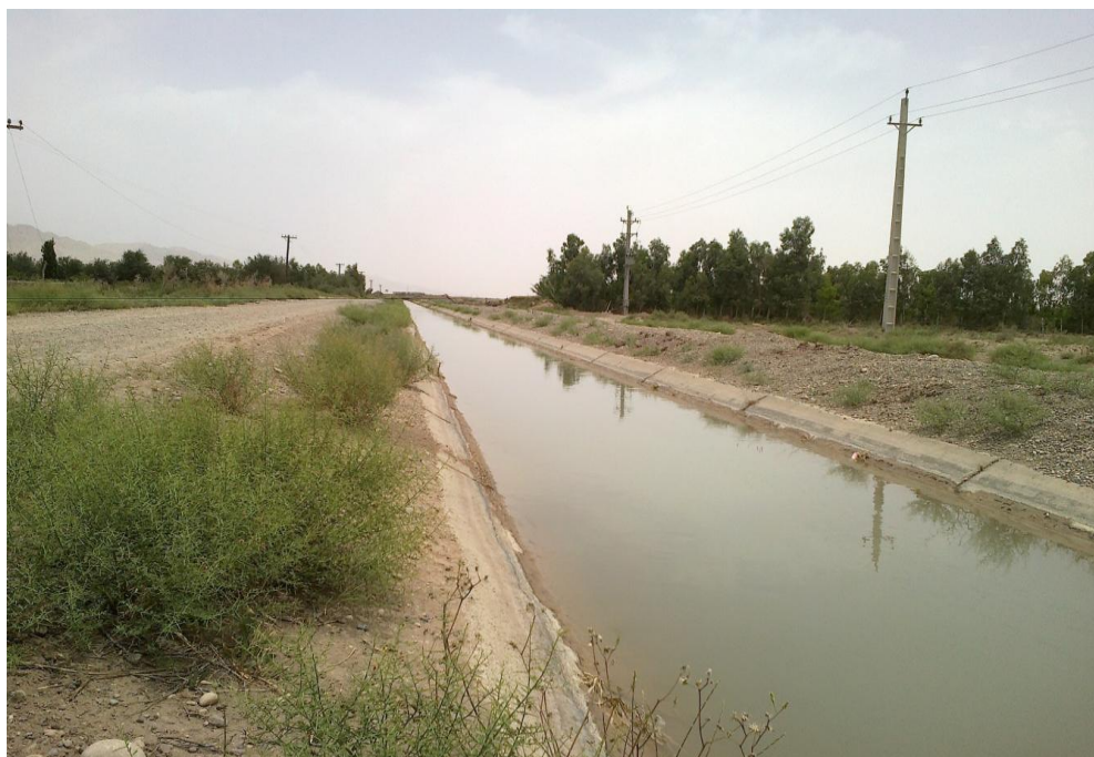
شکل ۴-۴- بالازدگی آب در کانال انتقال به علت وجود سازه کنترل‌کننده در پایین‌دست
