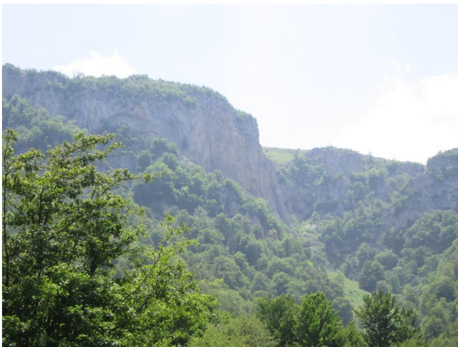
شکل ۳-۵۵- تصویر صحرایی از پرتگاه گسل لنگر (دید به سمت جنوب)؛
