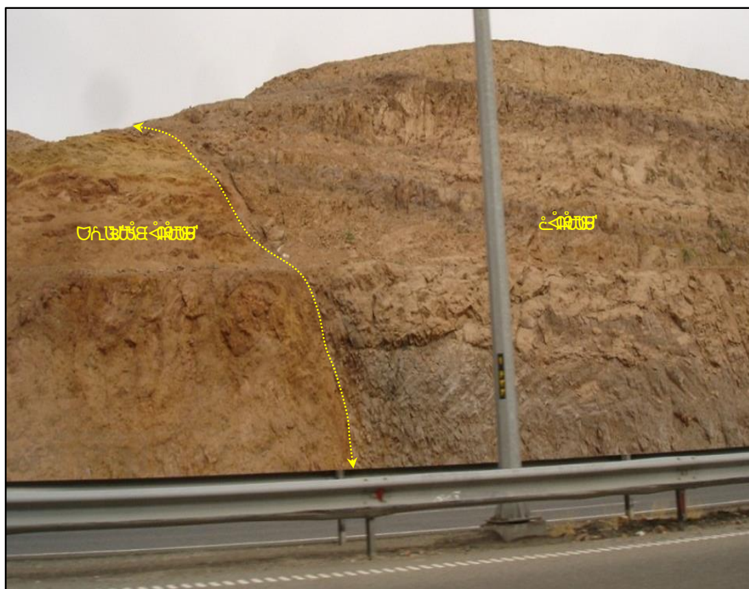
شکل ۳-۱۰ رخنمون گسل کوشک‌نصرت، ایستگاه شماره ۷، سمت نگاه خاور-شمال‌خاوری
