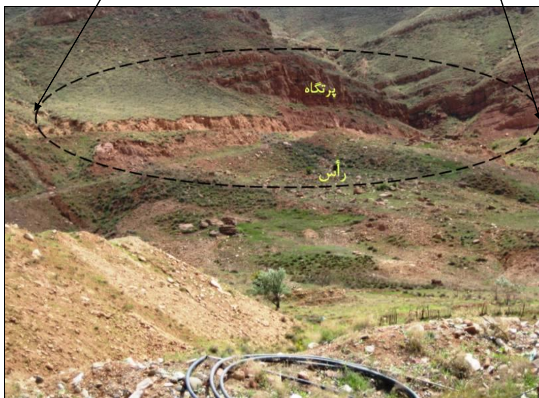
شکل (۴-۴) - زمین لغزش شماره ۱۳، پرتگاه و شگستگی‌های ناشی از زمین لغزش عمیق در جناح چپ سد (نگاه به سمت جنوب)
