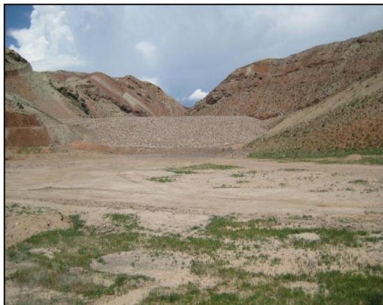
شکل (۳-۵) - دایک‌های احداث شده برای جلوگیری از نفوذ آب مخزن به واحد سنگی Mm (سمت راست مخزن سد، نزدیک شهر خواجه)
