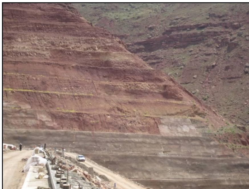
شکل (۴-۳۴) - روش سکوبندی یا پلکانی کردن و مش گذاری و بتن پاشی برای پایدارسازی دامنه چپ سد و نیار
