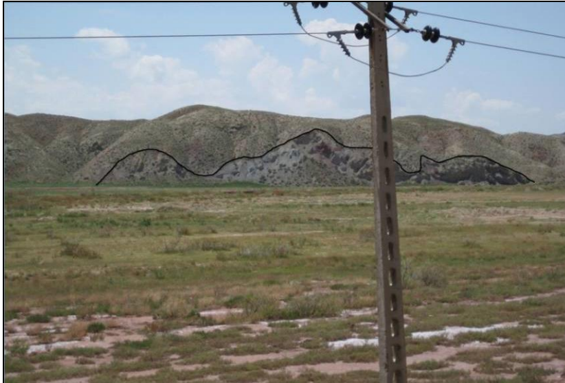
شکل (۴-۱۰) - تصویری از یک زمین لغزش سطحی رخ داده در واحد سنگی میوسن مارن دار (نگاه به سمت جنوب شرق)
