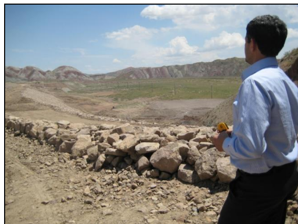
شکل (۳-۵) - دایک‌های احداث شده برای جلوگیری از نفوذ آب مخزن به واحد سنگی Mm (سمت راست مخزن سد، نزدیک شهر خواجه)
