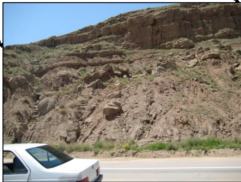
شکل (۴-۸) - زمین لغزش شماره ۶، از نوع انتقالی، در اثر پاشویی رودخانه و جاده سازی رخ داده است (نگاه به سمت شمال غرب)
