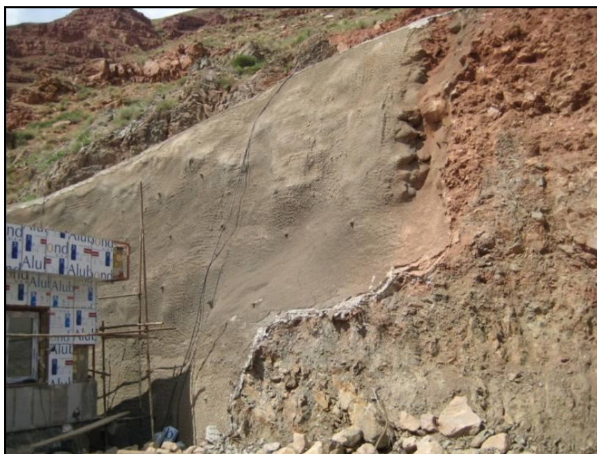
شکل (۴-۳۳) - مش گذاری و بتن پاشی برای پایدارسازی دامنه راست سد و نیار
