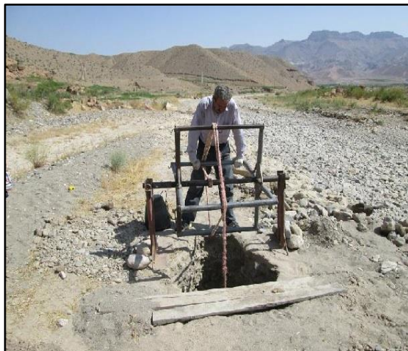
شکل ۳-۱۴. حفر چاهک‌های اکتشافی به طریقه‌ی سنتی توسط مقنی‌های محلی.
