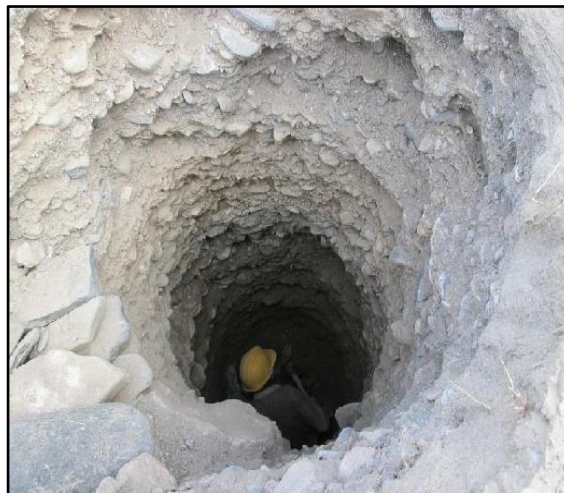
شکل ۳-۱۴. حفر چاهک‌های اکتشافی به طریقه‌ی سنتی توسط مقنی‌های محلی.
