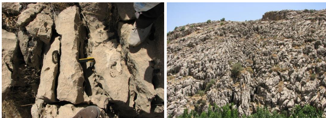
شکل ۵-۱۹- شکستگی‌های موجود در آهک بیستون در منطقه مورد مطالعه
