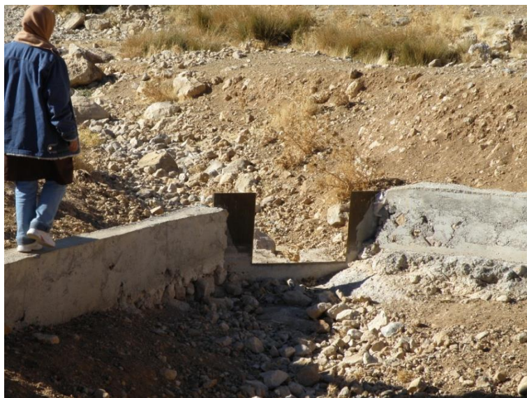
شکل ۱-۳- سرریز مستطیلی که برای محاسبه دبی چشمه امام‌قیس بر روی کانال جریان احداث شده است.
