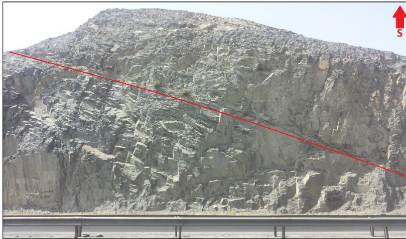
شکل ۳-۸۸- تصویر صحرایی ایستگاه شماره چهار گسل نظم آباد قسمت جنوبی جاده. دید عکس به سمت جنوب.
