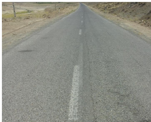
شکل ۳-۶۶- تصویر ترک موجود در جاده منطبق با امتداد گسل. دید به سمت خاور
