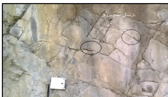
شکل ۳-۶۸- تصویری از بازشدگی سطح درزه به همراه سطح ناهموار درزه دید عکس جنوب خاور
