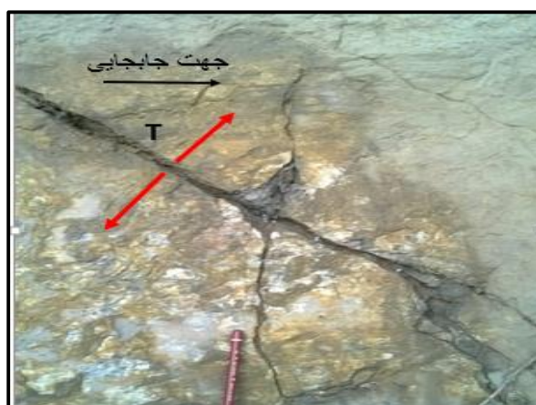
شکل ۳-۳۵- شکستگی کششی روی سطح گسل با موقعیت N85^{\circ}E 58^{\circ}SE فلش نشانگر جهت حرکت بلوک گمشده است دید عکس شمال - شمال خاور
