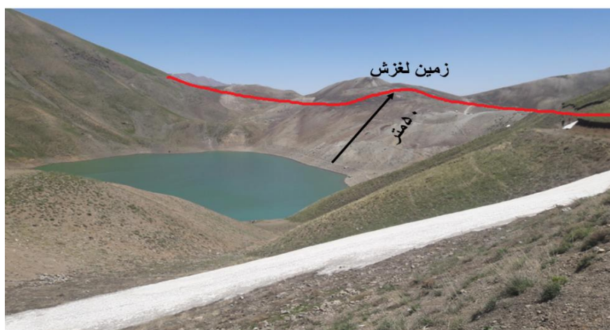
شکل ۱-۷- پدیده زمین لغزش (جنوب شرقی)
