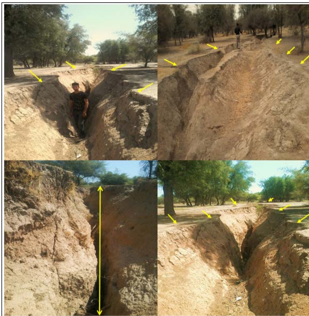
شکل ۴-۲۴: تصاویری از شکاف اصلی ایجاد شده در دشت کردی شیرازی در نقاط مختلف
